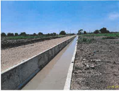
ภาพที่ 2.2-11 (ต่อ) รางระบายน้ำฝน และบ่อดักตะกอน
