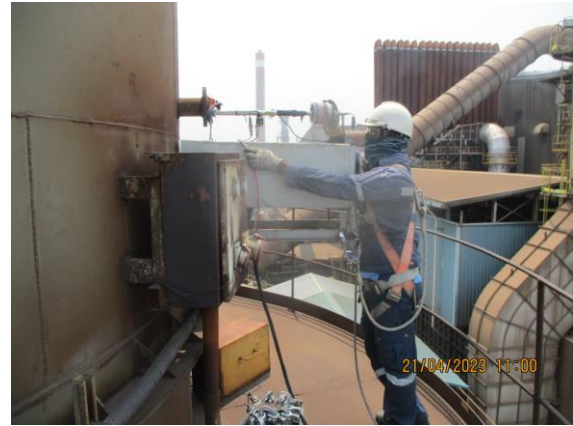
รูปที่ 4-47 ตรวจวัดปล่องที่ผ่านโรงกำจัดฝุ่น (Fume Plant # 1) ตรวจวัดในวันที่ 21 เมษายน 2566
