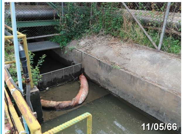
รูปที่ 3-22 ประตูกั้นน้ำบริเวณด้านหลังโรงงาน และฝ่ายชะลอน้ำและระบบกรองเพื่อลดปริมาณของแข็งแขวนลอย
