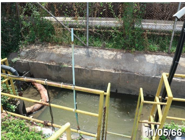
รูปที่ 3-22 ประตูกั้นน้ำบริเวณด้านหลังโรงงาน และฝ่ายชะลอน้ำและระบบกรองเพื่อลดปริมาณของแข็งแขวนลอย
