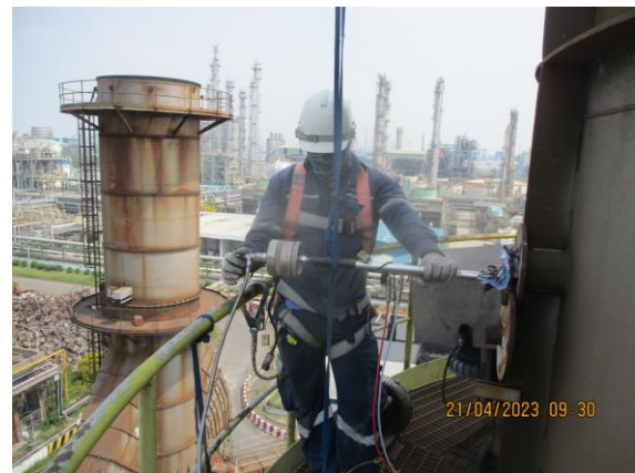
รูปที่ 4-49 ตรวจวัดปล่องที่ผ่านโรงกำจัดฝุ่น (Fume Plant # 2) ตรวจวัดในวันที่ 21 เมษายน 2566
