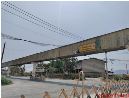
รูปที่ 5 สายพานลำเลียงที่ผ่านชุมชนมีฝาครอบปิดมิดชิด
