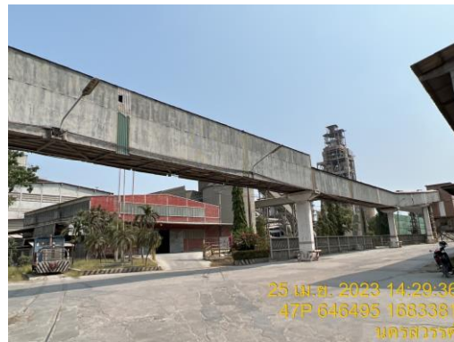
รูปที่ 5 สายพานลำเลียงที่ผ่านชุมชนมีฝาครอบปิดมิดชิด
