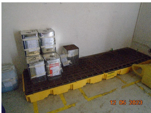
ภาพที่ 2.2-16 ถังหรือภาชนะที่เก็บสารเคมีที่เป็นของเหลว ถูกจัดวางไว้บนถาดรองรับ
