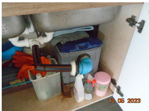
ภาพที่ 2.2-10 บ่อพักไขมันภายในห้องพักผู้โดยสารของศูนย์ขนส่งทางอากาศของบริษัทฯ
