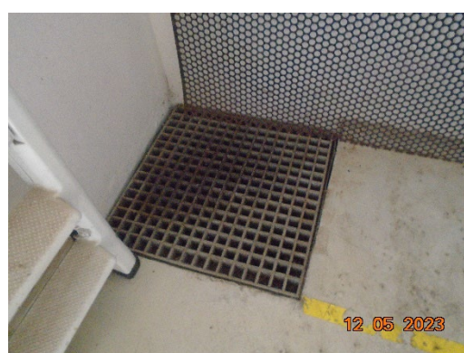
ภาพที่ 2.2-23 บ่อเก็บกักสารเคมีภายในห้องเก็บสารเคมี ของศูนย์ขนส่งทางอากาศของบริษัทฯ
