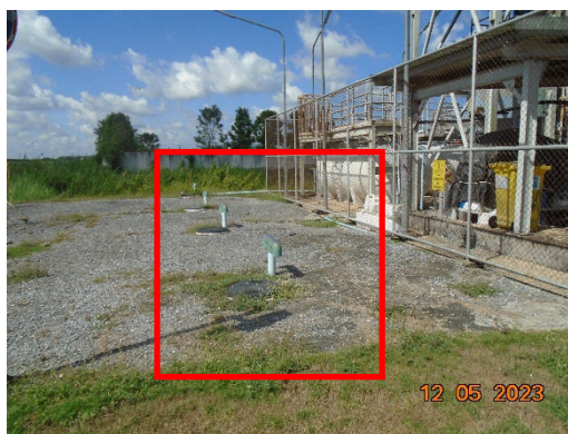
ภาพที่ 2.1-8 ถังเก็บรวบรวมน้ำเสียจากการล้างเฮลิคอปเตอร์ (ถังใต้ดิน) ในกรณีที่ระบบบำบัดน้ำเสียไม่สามารถทำงานได้
