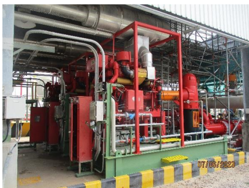
ภาพที่ 2.1-53 ระบบการสูบน้ำดับเพลิง
