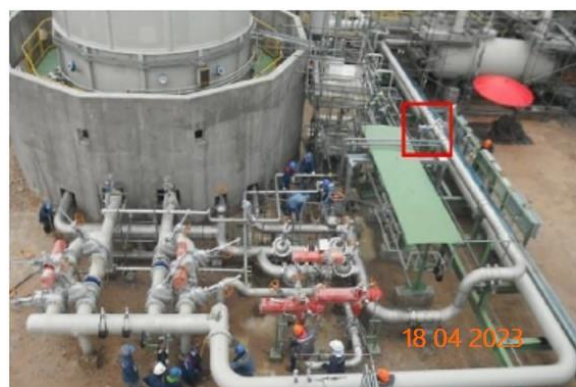
ภาพที่ 2.1-14 เครื่องมือวัดอัตราการไหล (Flow Meter)
