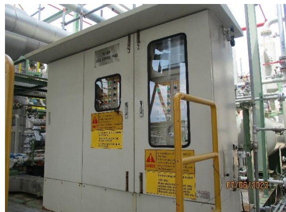
ภาพที่ 2.1-8 ตู้ควบคุมการทำงานของระบบ Boil of Gas (BOG)
