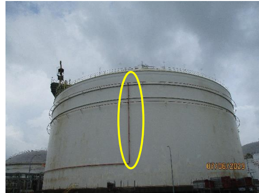
ภาพที่ 2.1-38 การติดตั้งระบบน้ำฉีด รอบผนังเพื่อลดอุณหภูมิ
