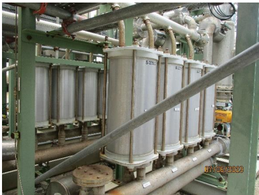
ภาพที่ 2.1-11 ระบบกรองอากาศแบบ Membrane ของหน่วยแยกไอระเหย (VRU)
