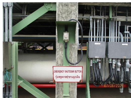
ภาพที่ 2.1-54 ระบบ Emergency Release System (ERS) บริเวณ Loading Arm ของท่าเทียบเรือ
