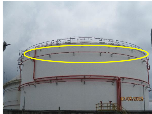
ภาพที่ 2.1-46 ระบบตรวจจับความร้อน (Linear Heat Detector)
