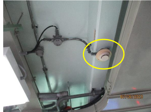
ภาพที่ 2.1-44 ระบบตรวจจับควัน (Smoke Detector)
