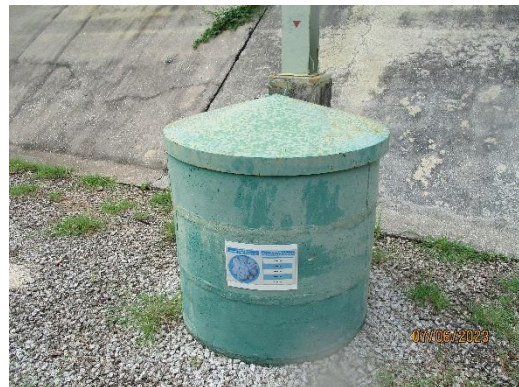
ภาพที่ 2.1-40 ถังทรายแห้ง สำหรับใช้ในกรณีการหกรั่วไหลของสารเคมี
