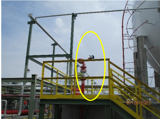
ภาพที่ 2.1-43 ระบบหัวฉีดน้ำดับเพลิง (Fixed Monitor)
