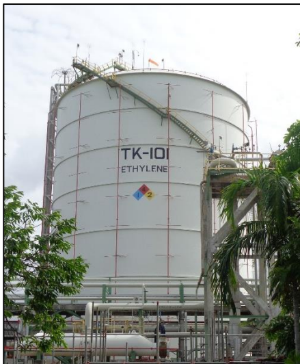
ถังทรงกระบอก มีฝาถังแบบ Cone Roof
