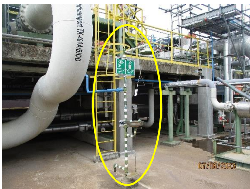
ภาพที่ 2.1-47 ฝักบัวฉุกเฉิน และอ่างล้างตา บริเวณท่าเทียบเรือ
