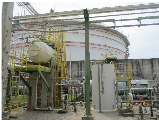
ภาพที่ 2.1-21 ระบบ API Separator
