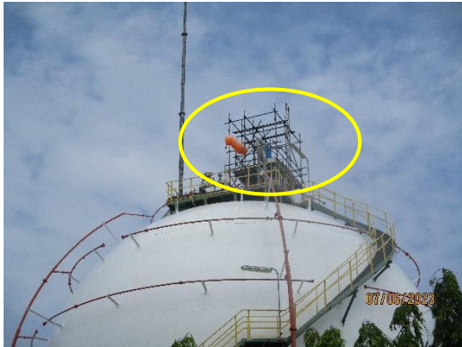
ภาพที่ 2.1-37 ระบบวาล์วควบคุมความดันของถัง
