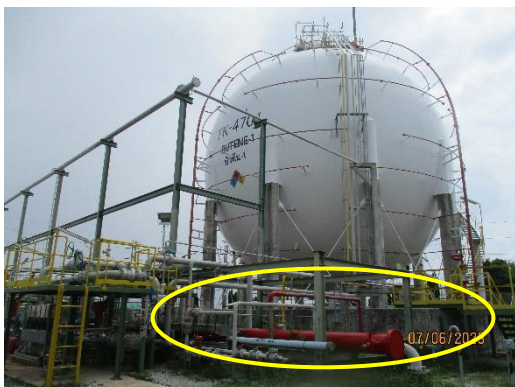
ภาพที่ 2.1-41 ระบบการสูบน้ำดับเพลิงเข้า ถังเก็บบีวทีน-1 และ C4's Derivative
