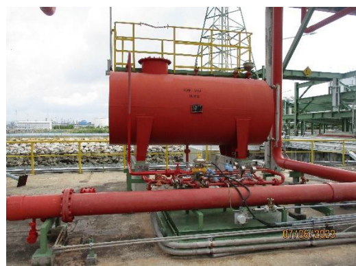
ภาพที่ 2.1-42 ระบบโฟมชนิดอยู่กับที่ (Fixed Foam Unit)
