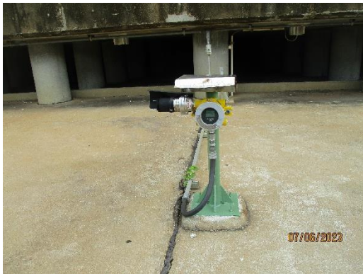
ภาพที่ 2.1-45 อุปกรณ์ตรวจวัดก๊าซในบรรยากาศ (Gas Detector) แบบติดตั้งอยู่กับที่
