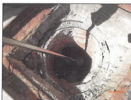
(2) บ่อตรวจสอบคุณภาพน้ำทั้งหลังออกจากระบบบำบัดน้ำเสีย ตึก A
