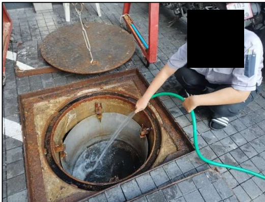
รูปที่ 2-21 การตรวจสอบและการทำความสะอาดบ่อบำบัดน้ำ
