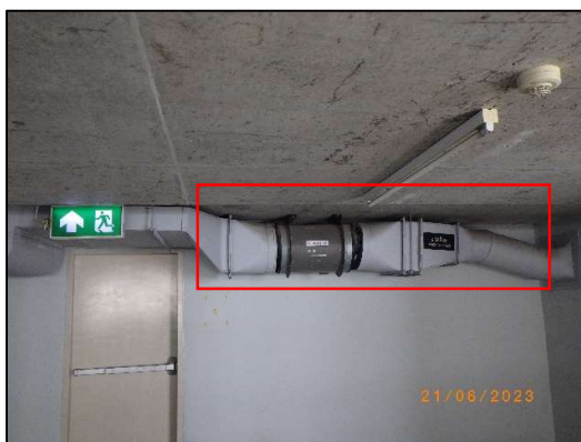
รูปที่ 2-10 พัฒนาระบายอากาศที่อาคารจอดรถ
