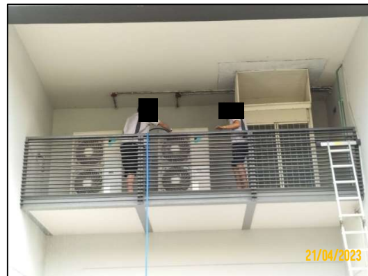
รูปที่ 2-53 การล้างเครื่องปรับอากาศ บริเวณพื้นที่ส่วนกลาง
