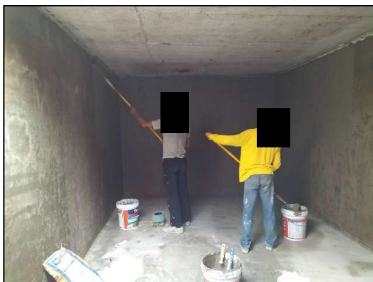
รูปที่ 2-66 ทากันซึมถึงเก็บน้ำใช้
