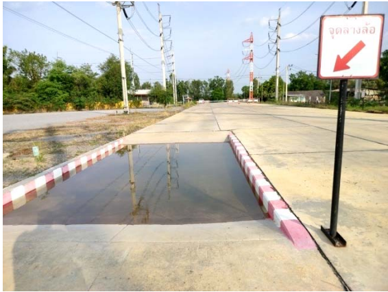
รูปที่ 2-33 พื้นที่ล้างล้อรถบรรทุก ก่อนออกนอกพื้นที่โครงการ
