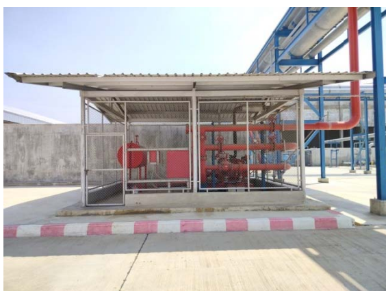
รูปที่ 2-53 เครื่องสูบน้ำดับเพลิง (Fire pump)
