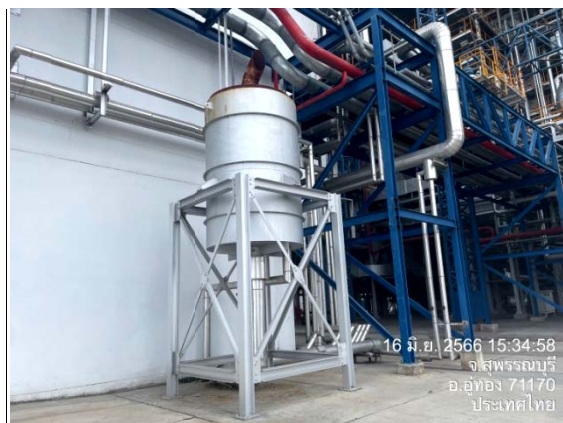
รูปที่ 2-9 การติดตั้งอุปกรณ์ป้องกันเสียงดัง (Silencer)
