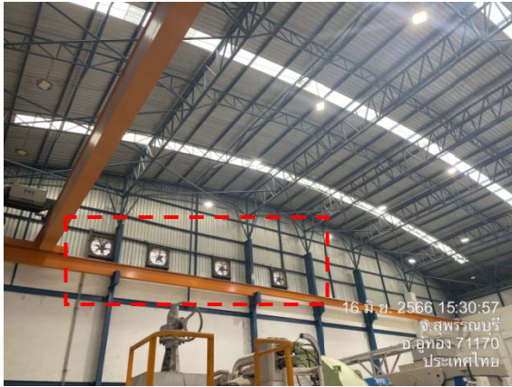
รูปที่ 2-47 ระบบระบายอากาศ
