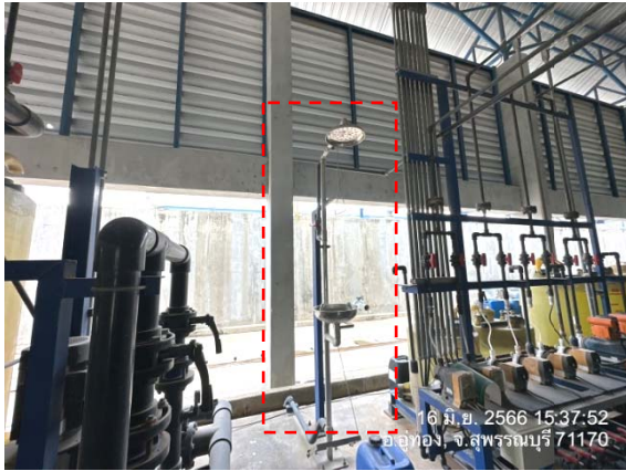
รูปที่ 2-42 อ่างล้างตาฉุกเฉิน และฝักบัวฉุกเฉิน
