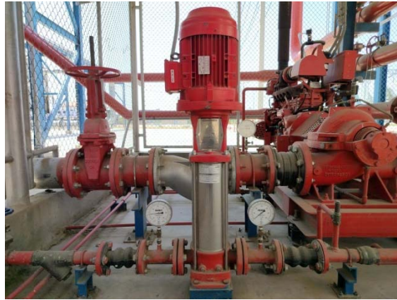
รูปที่ 2-54 เครื่องสูบน้ำแรงดัน (Jocky pump)
