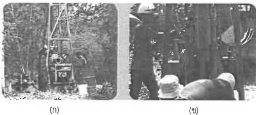
รูปที่ 14: การเก็บตัวอย่างดินโดยใช้เครื่องจักรเจาะเจาะ (ก) บั่นจั่น (ข) ดึงน้ำหนักที่ใช้ตอก
