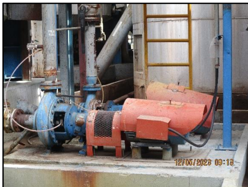
ภาพที่ 2.33 การปิดครอบสายพานเครื่องจักร (ต่อ)
