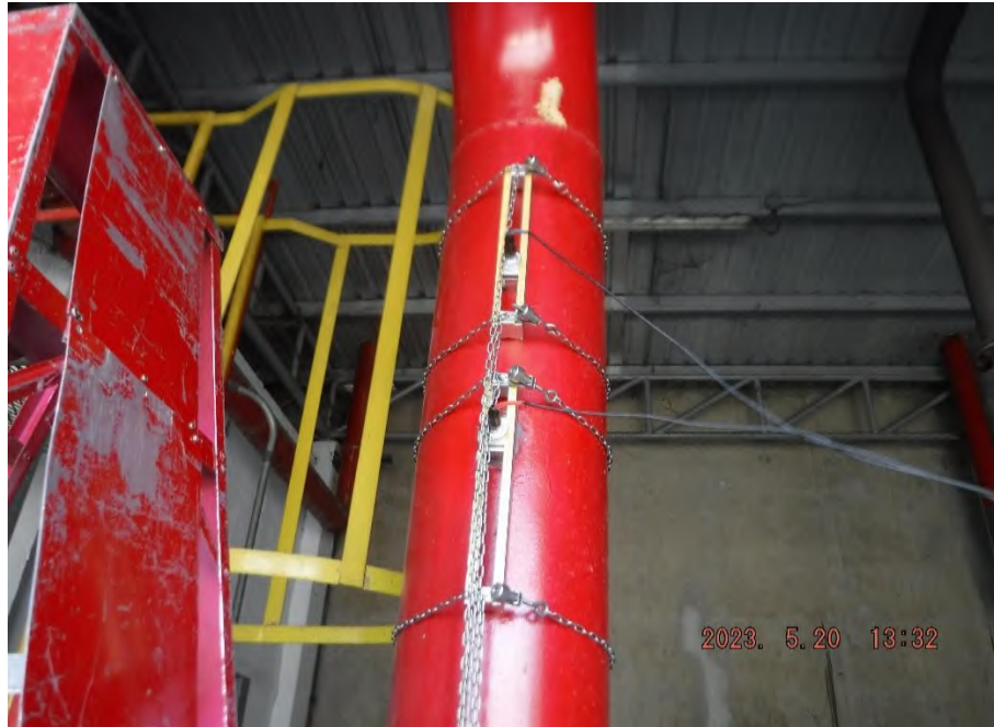
รูปที่ 1 การติดตั้งเซ็นเซอร์ (Sensor) ของเครื่องมือวัดอัตราการไหลของน้ำ (Flow Rate) ภายในเส้นท่อน้ำดับเพลิง
