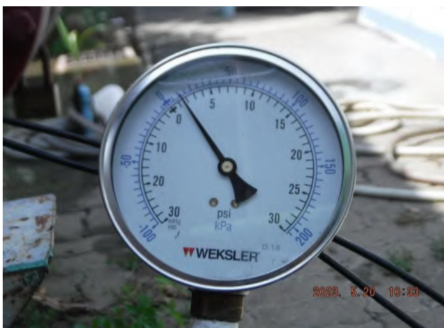
รูปที่ 23 Suction Pressure ที่อ่านค่าได้เท่ากับ 1.6 psi.
