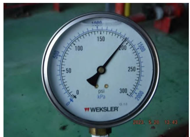
รูปที่ 4 Discharge Pressure ที่อ่านค่าได้เท่ากับ 194 psi.
