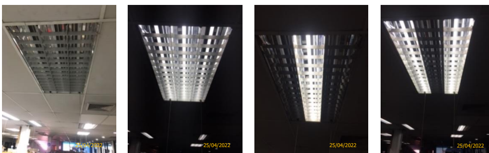
ภาพที่ 3.89 การติดตั้งสวิทช์ไฟชนิดดิ่งที่โคมที่สามารถปิดไฟบางส่วน
