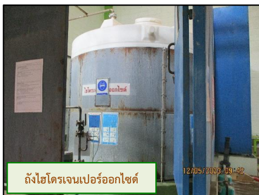
ภาพที่ 2.18 ตัวอย่างรายละเอียดและการแบ่งถังกักเก็บของเหลวแบบสีต่างๆ
