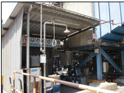
ภาพที่ 2.30 ฝักบัวลูกเดินภายนอกและภายในตัวอาคาร
