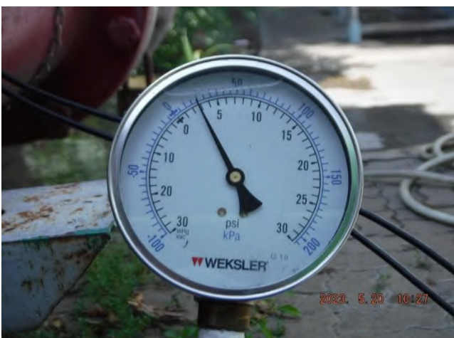
รูปที่ 11 Suction Pressure ที่อ่านค่าได้เท่ากับ 2.9 psi.
