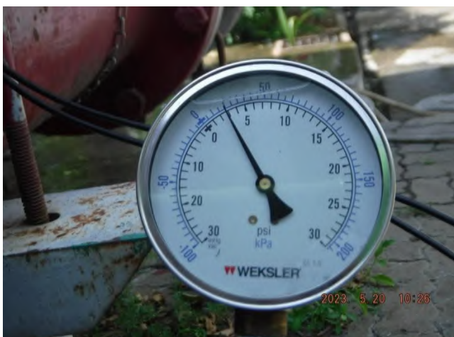
รูปที่ 7 Suction Pressure ที่อ่านค่าได้เท่ากับ 3 psi.
