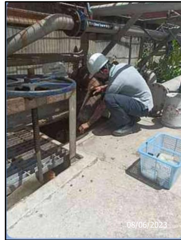
ภาพที่ 3.3 การตรวจวัดคุณภาพน้ำ บริเวณหลังผ่านระบบบำบัดน้ำเสีย (จุดออก ETP No.3)
