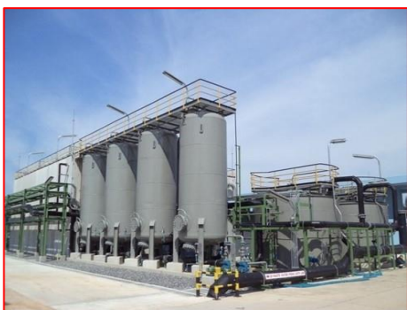
ภาพที่ 2.2-5 ระบบบำบัดน้ำเสีย ส่วนกลางหน่วยที่ 3
