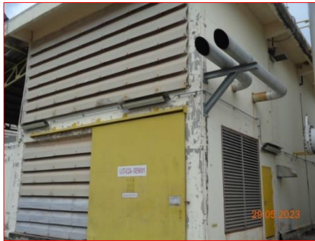
ภาพที่ 2.2-11 การติดตั้งอุปกรณ์ที่ทำให้เกิดเสียงดังในห้องปิด
