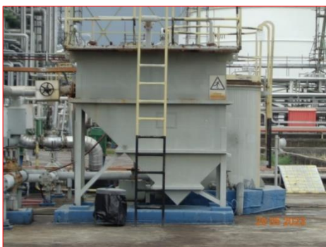
ภาพที่ 2.2-3 ระบบบำบัดน้ำเสียเบื้องต้น CPI
