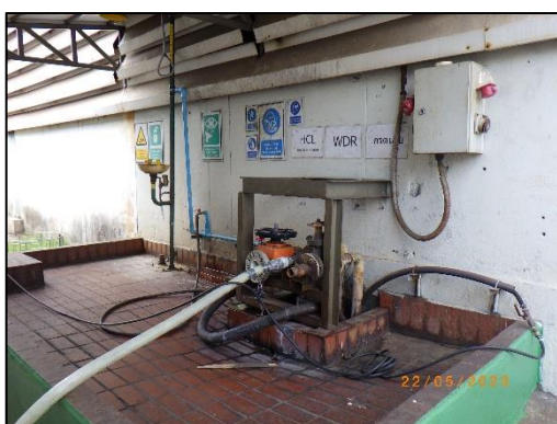
รูปที่ 2-48 Bund wall บริเวณจุดเติมและรับกรดไฮโดรคลอริก
