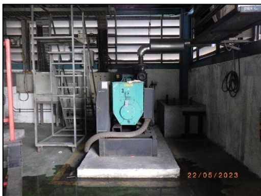
รูปที่ 2-2 เครื่องกำเนิดไฟฟ้าสำรอง (Emergency Generator) สำหรับระบบ Scrubber
