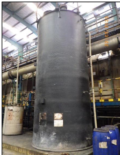
ถังเก็บกากน้ำกรดที่ทำจากวัสดุทนการกัดกร่อน บริเวณพื้นที่รองรับถังเก็บกากที่ทำจากวัสดุทนการกัดกร่อน รูปที่ 2-10 ถังเก็บกากน้ำกรด (จากขั้นตอนการล้างด้วยกรดไฮโดรคลอริก) และบริเวณโดยรอบ
