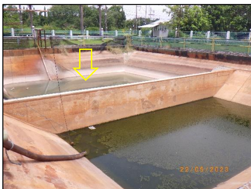
บ่อพักน้ำทิ้งขนาด 400 ลูกบาศก์เมตร (Effluent Pond)
