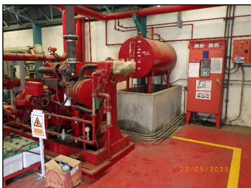
รูปที่ 2-53 เครื่องสูบน้ำดับเพลิงภายในโครงการ
