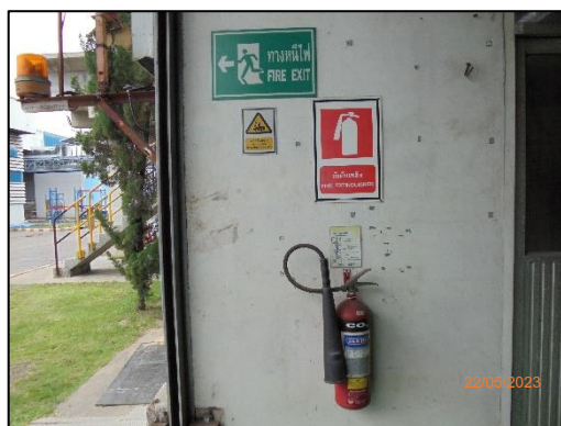
รูปที่ 2-50 อุปกรณ์ดับเพลิงภายในโครงการ
