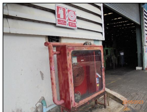
รูปที่ 2-52 ท่อน้ำดับเพลิงและหัวจ่ายน้ำดับเพลิงภายในโครงการ
