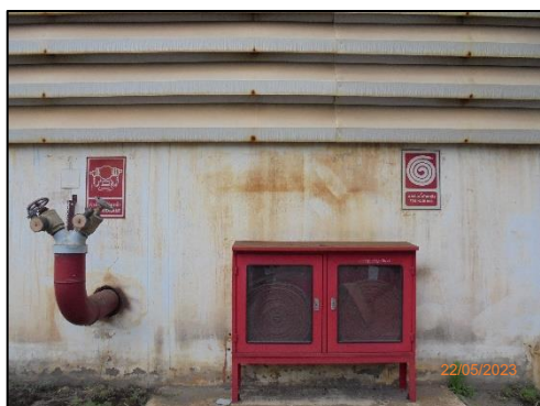
รูปที่ 2-52 ท่อน้ำดับเพลิงและหัวจ่ายน้ำดับเพลิงภายในโครงการ
