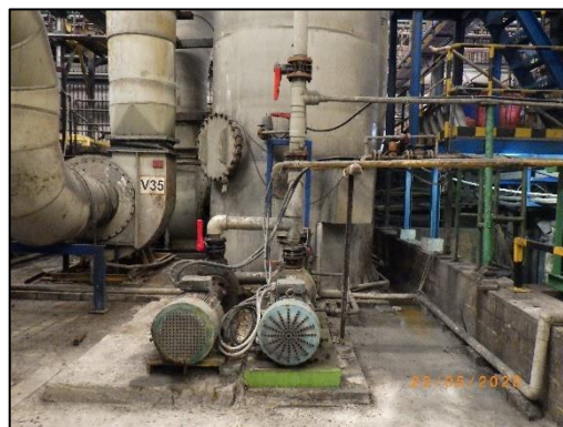
รูปที่ 2-3 ปั๊มน้ำที่ใช้ในระบบ Scrubber
