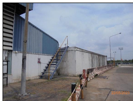
รูปที่ 2-16 บ่อสำรองน้ำดับเพลิง
