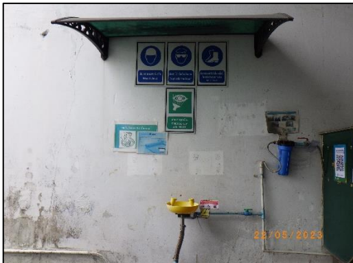
รูปที่ 2-34 ฝักบัวและอ่างล้างตาฉุกเฉินภายในโครงการ
