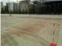
ภาพตัวอย่างการติดตั้งเสาและล้อมพื้นที่ด้วยแปะขาว-แดง
