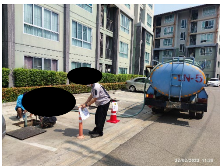
ภาพที่ 2.2-12 การสูบน้ำจากตะกอน ตักตะกอน ไชมัน
