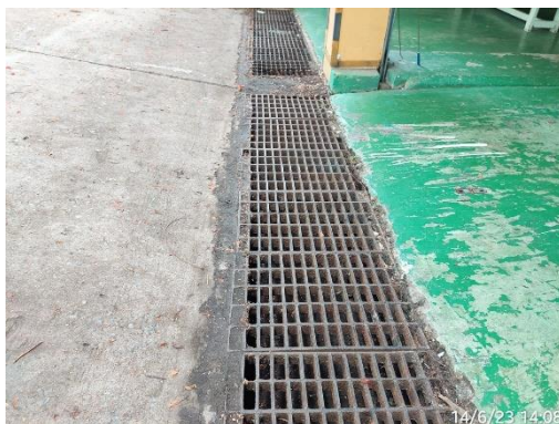
รูปที่ 2-8 ตะแกรงดักมูลฝอย บริเวณจุดระบายน้ำ เข้าสู่ท่อระบายของโครงการ
