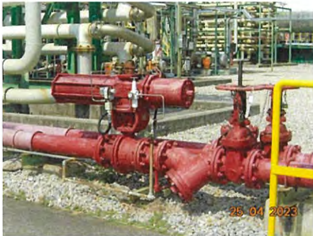
ภาพที่ 2-15 Interlock Valve
