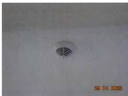
ภาพที่ 2-26 Smoke Detector
