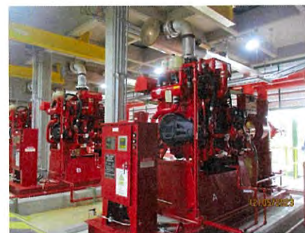
ภาพที่ 2-36 ปั้มน้ำดับเพลิง (Fire Pump)
