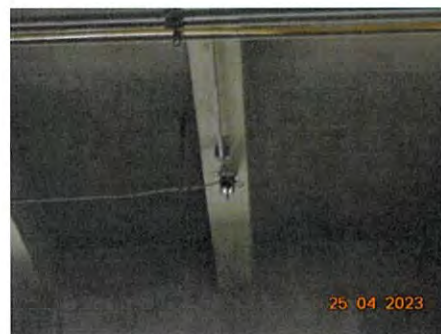
ภาพที่ 2-25 Heat Detector
