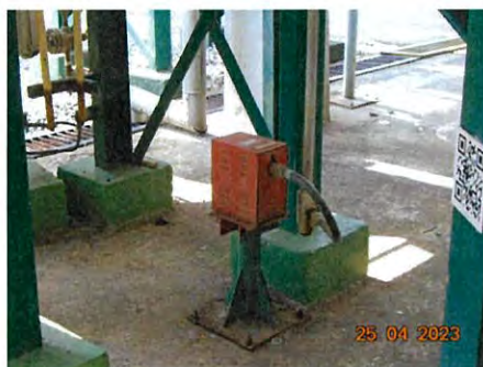
ภาพที่ 2-24 Gas Detector
