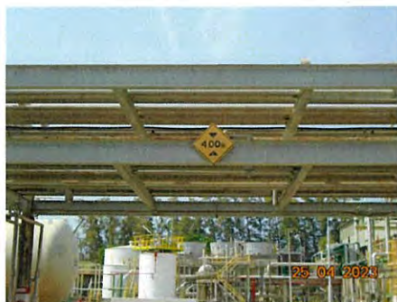
ภาพที่ 2-22 ท่อลำเลียงอยู่บนฐานรองรับเหนือพื้นพร้อมป้ายเตือนจำกัดความสูง
