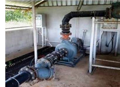
เครื่องสูบน้ำ ติดตั้งที่บ่อหนองน้ำ ขนาด 18,000 ลบ.ม. สูบน้ำออกสู่ลำคลอง ด้วยกำลัง 210 ลบ.ม./ชม (1 เครื่อง)
