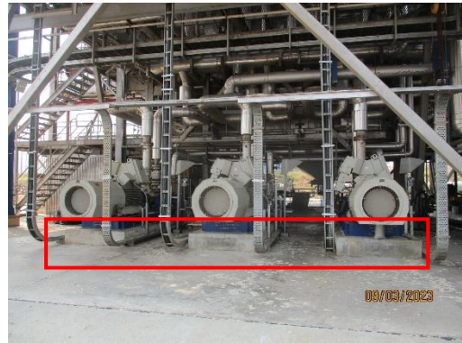
รูปที่ 31 แท่นรองเครื่องจักร
