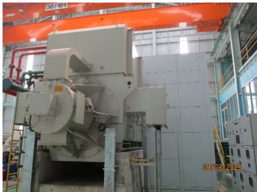
รูปที่ 26 การปิดครอบเครื่องจักรที่มีเสียงดัง
