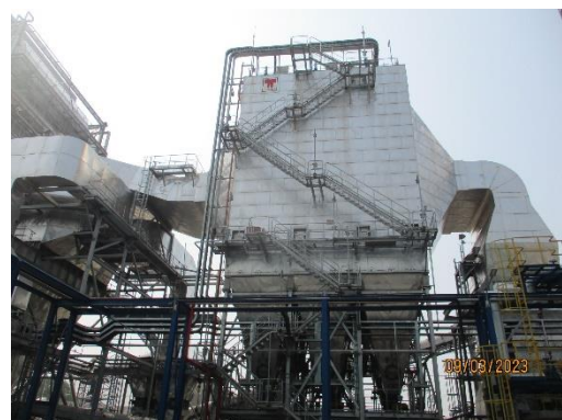
รูปที่ 3 การติดตั้งระบบบำบัดมลพิษทางอากาศ
