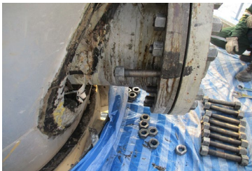
ลักษณะของ Stud bolt ที่ใส่ค้างอยู่ที่หน้าแปลน
