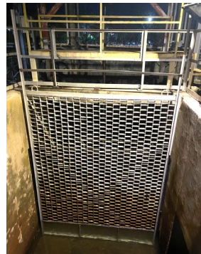
ภาพประตูน้ำหลังการติดตั้งแผ่น Plate
