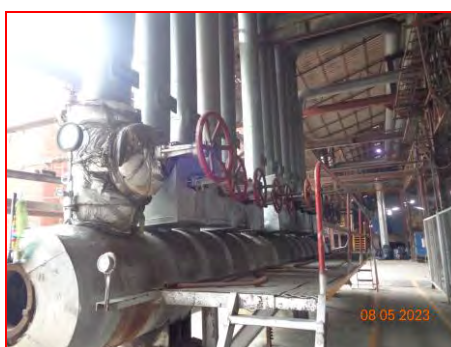
ภาพที่ 2.2-62 วาล์วควบคุม (Control valve) บริเวณกังหันไอน้ำ
