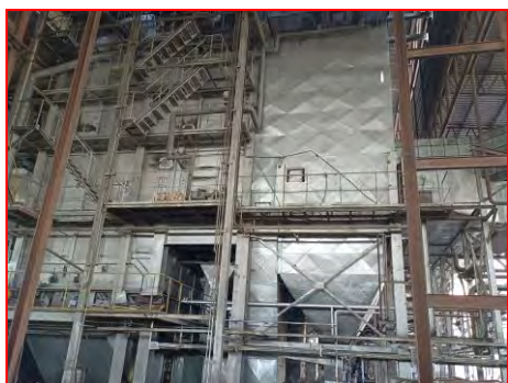
ภาพที่ 2.2-5 อุปกรณ์ดักฝุ่นแบบ Multi Cyclone
