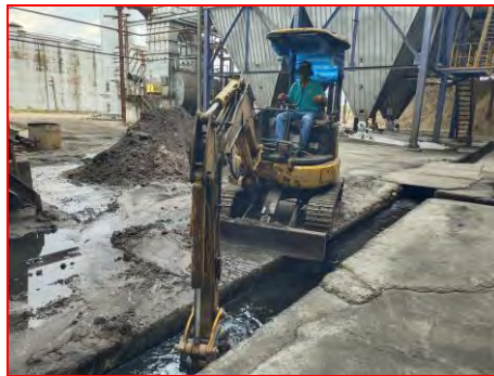
ภาพที่ 2.2-34 การขุดลอกตะกอนจากรางระบายน้ำฝน
