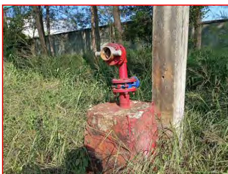
ภาพที่ 2.2-60 ท่อน้ำดับเพลิง รอบลานกองเก็บกากอ้อย
