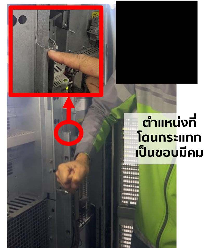
ภาพ C การจำลองเหตุการณ์ แขนขวากระแทกโดนโครงของตู้ VSD
