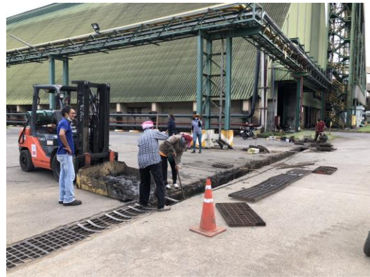
รูปที่ 34 การขุดลอกกระบระบายน้ำ
