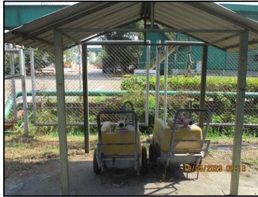
ภาพที่ 2.43 ระบบดับเพลิง ชนิด Mobile Foam บริเวณลานสุบถ่าย
