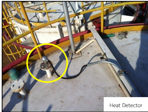
ภาพที่ 2.48 Flame Detector และ Heat Detector
