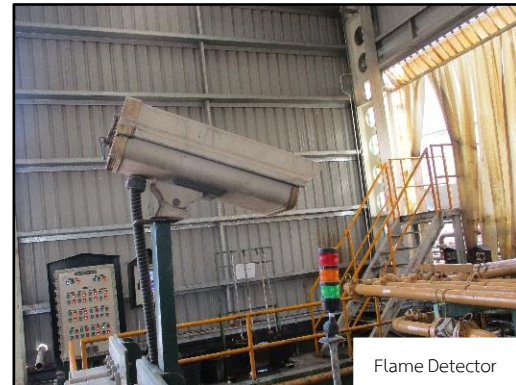
ภาพที่ 2.48 Flame Detector และ Heat Detector
