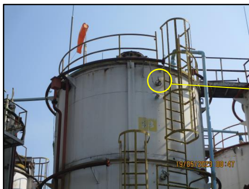
ภาพที่ 2.46 ระบบ High & Low Level Sensor
