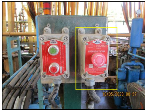
ภาพที่ 2.45 Emergency Stop บริเวณลานสูบน้ำ
