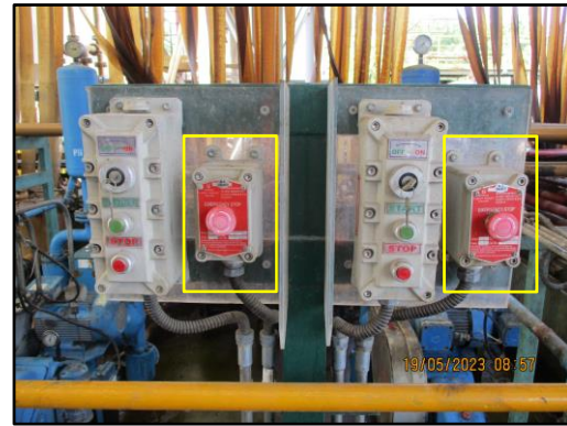
ภาพที่ 2.45 Emergency Stop บริเวณลานสูบน้ำ
