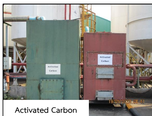
ภาพที่ 2.4 ระบบบำบัดมลพิษทางอากาศที่เป็นไอระเหยสารอินทรีย์จาก Breathing Valve
