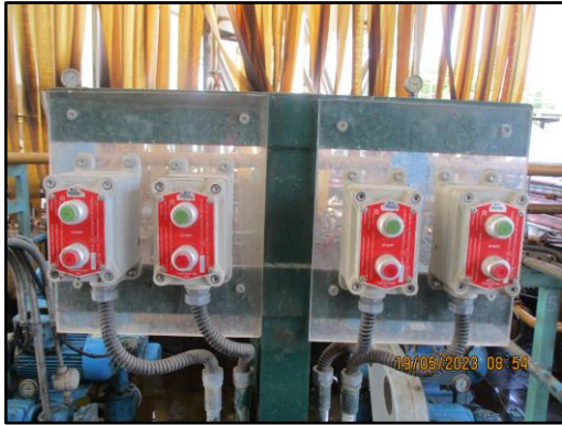
ภาพที่ 2.40 ระบบ Interlock และการต่อสายดิน
