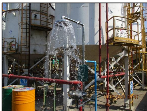
ภาพที่ 2.36 ฝักบัวและอ่างล้างตาสำหรับชำระล้างร่างกายและล้างตาเมื่อเกิดเหตุฉุกเฉิน
