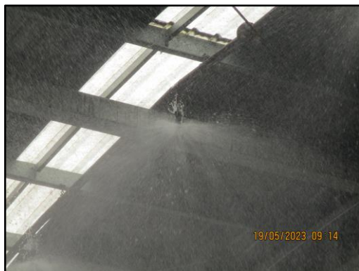
ภาพที่ 2.50 ระบบ Sprinkler บริเวณอุปกรณ์ควบคุมการสุบถ่าย
