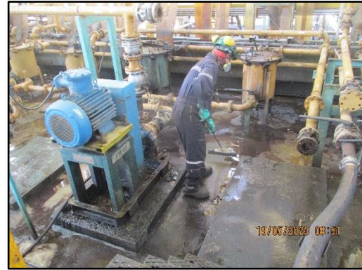
ภาพที่ 2.6 เจ้าหน้าที่ทำความสะอาดเครื่องสูบน้ำ อุปกรณ์สูบน้ำหลังสิ้นสุดการสูบน้ำกากของเสีย
