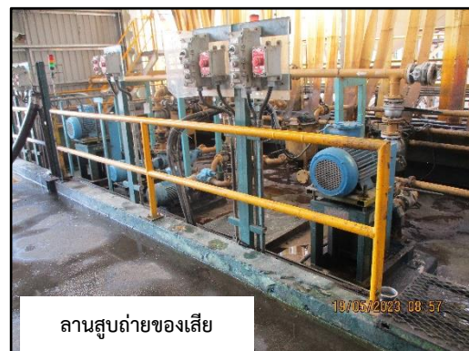
ภาพที่ 2.7 คันกันที่เป็นขอบ (Curb) โดยรอบบริเวณลานสูบน้ำ และลานดักเก็บ
