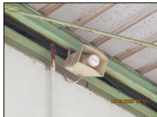
ภาพที่ 2.56 สวิตช์และกริ่งสัญญาณแจ้งเตือนเมื่อเกิดเหตุฉุกเฉิน
