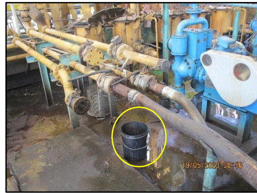
ภาพที่ 2.12 Bund และถาดรองรับบริเวณข้อต่อระหว่างท่ออ่อนกับเครื่องสูบน้ำ
