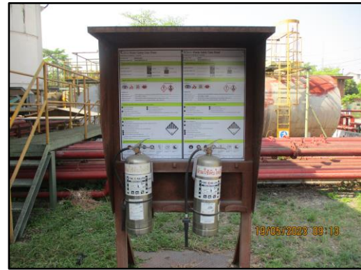
ภาพที่ 2.55 ถังดับเพลิงแบบมือถือชนิดถังโฟม
