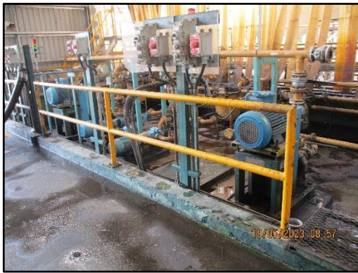
ภาพที่ 2.12 Bund และถาดรองรับบริเวณข้อต่อระหว่างท่ออ่อนกับเครื่องสูบน้ำ
