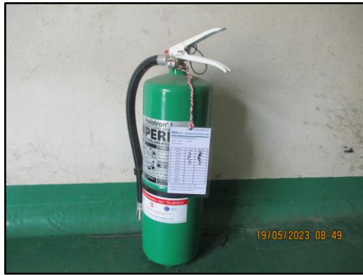
ภาพที่ 2.54 ถังดับเพลิงแบบมือถือชนิดเคมีแห้ง
