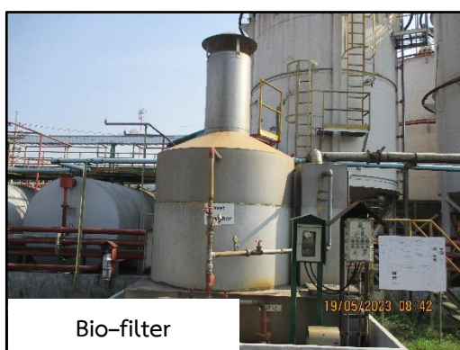
ภาพที่ 2.4 ระบบบำบัดมลพิษทางอากาศที่เป็นไอระเหยสารอินทรีย์จาก Breathing Valve
