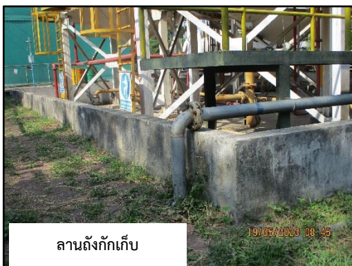
ภาพที่ 2.7 คันกันที่เป็นขอบ (Curb) โดยรอบบริเวณลานสูบน้ำ และลานดักเก็บ
