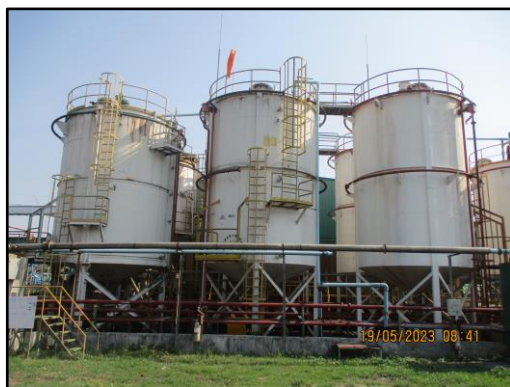
ภาพที่ 2.47 Cooling Ring บริเวณด้านบนของถังกักเก็บ
