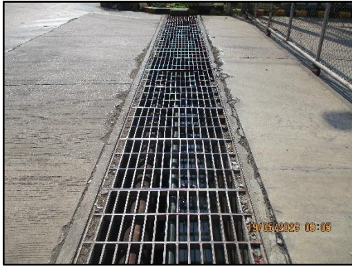
ภาพที่ 2.10 รางระบายน้ำฝนรอบ บริเวณลานสูบน้ำ
