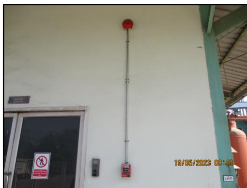
ภาพที่ 2.56 สวิตช์และกริ่งสัญญาณแจ้งเตือนเมื่อเกิดเหตุฉุกเฉิน
