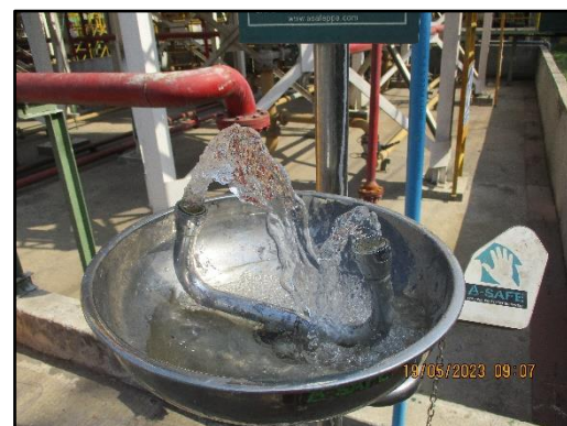
ภาพที่ 2.36 ฝักบัวและอ่างล้างตาสำหรับชำระล้างร่างกายและล้างตาเมื่อเกิดเหตุฉุกเฉิน
