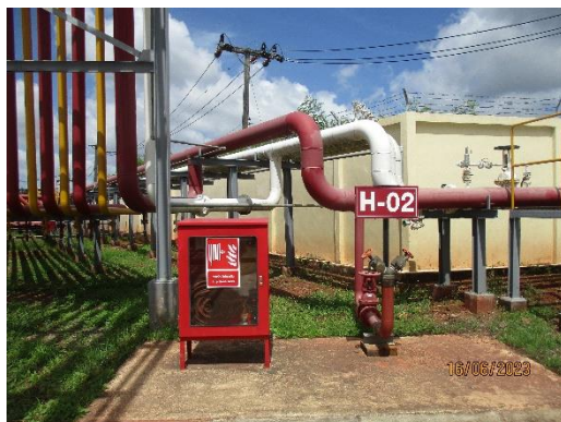
ภาพที่ 2-25 ระบบท่อน้ำดับเพลิงและสายฉีดน้ำดับเพลิง
