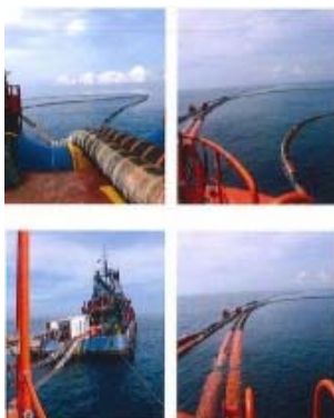
รูปที่ 3-34 การล้างทำความสะอาดท่อรับน้ำมัน
