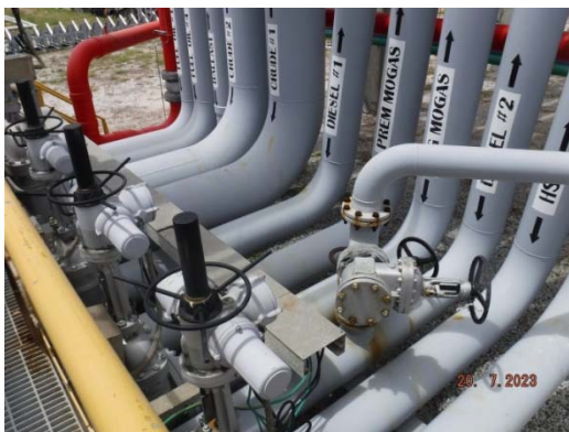
รูปที่ 3-2 ระบบหยุดปฏิบัติการฉุกเฉิน (Shore Line Block Valve)
