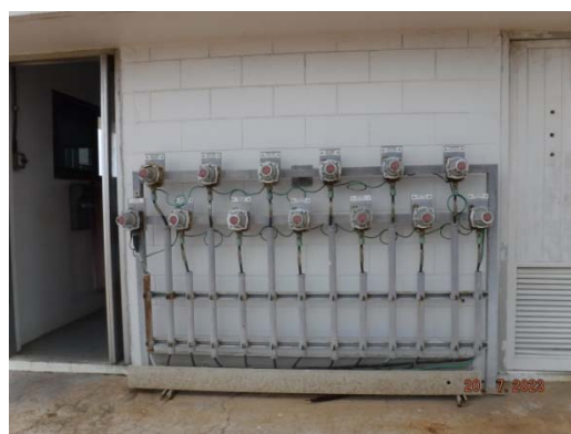
รูปที่ 3-29 Emergency Shut Off Valve ที่ Loading Arm
