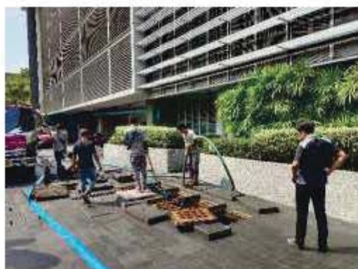
สูบลตะกอน และกากไขมันระบบบำบัดน้ำเสีย (04/02/66)
