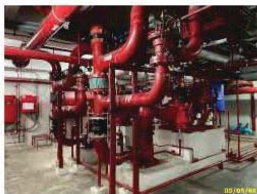
ถังเก็บน้ำดับเพลิง พร้อมระบบเครื่องสูบน้ำดับเพลิง
