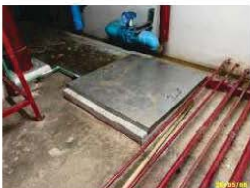
ถังเก็บน้ำดับเพลิง พร้อมระบบเครื่องสูบน้ำดับเพลิง
