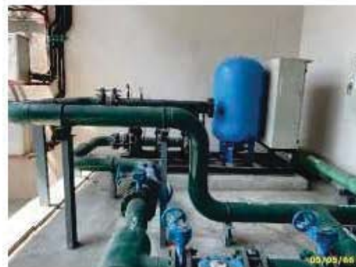
ถังเก็บน้ำชั้นดาฟ้า พร้อม Booster pump
