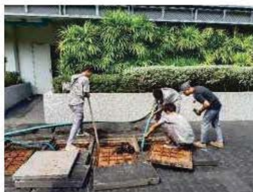
สูบลตะกอน และกากไขมันระบบบำบัดน้ำเสีย (04/02/66)
