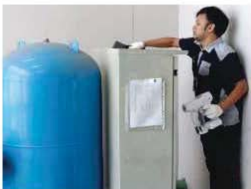
ถังเก็บน้ำดับเพลิง พร้อมระบบเครื่องสูบน้ำดับเพลิง
