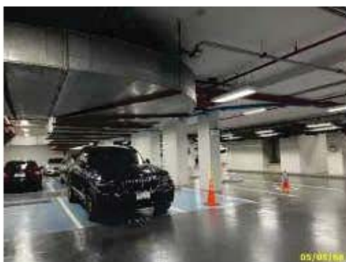
พัดลมระบายอากาศพื้นที่จอดรถชั้นใต้ดิน
