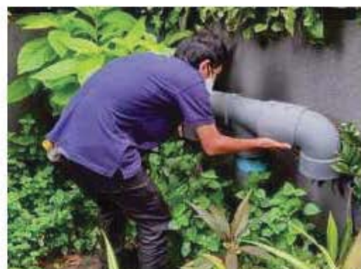
เจ้าหน้าที่เปลี่ยนผ่านตัวกลางระบบมีเทน และ Aerosol
