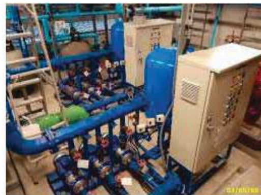
ถังเก็บน้ำชั้น 30 พร้อมเครื่องปั๊มน้ำ
