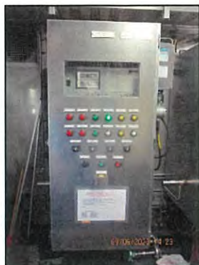
CEMs ที่ปล่อยระบายอากาศ Naphtha Cracking Heater A, B และ Recycle Cracking Heater R
