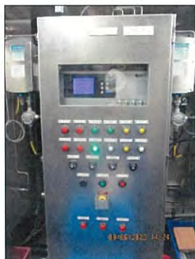
CEMs ที่ปล่อยระบายอากาศ Naphtha Cracking Heater F, G และ H
