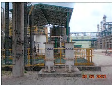
รูปที่ ก2-6 Carbon Canister ที่ใช้กำจัด Vent gas จาก Slop Oil Tank
