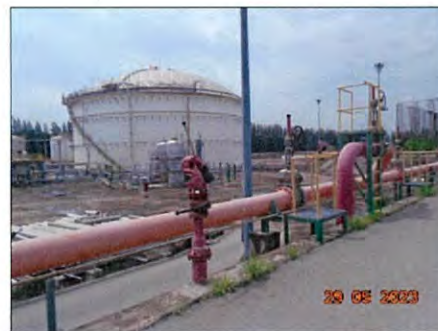
แท่นป่นฉีดน้ำดับเพลิง (Fixed Water Monitor)
