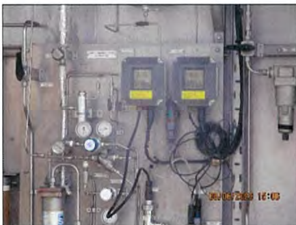
รูปที่ ก2-23 การติดตั้ง พีเอช (pH) Online ที่ Neutralization Tanks
