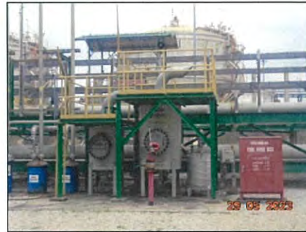
รูปที่ ก2-9 Carbon Canister บริเวณ Truck Loading
