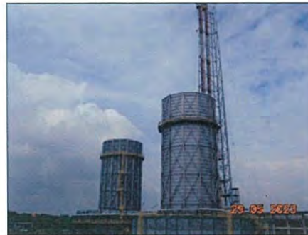
รูปที่ ก2-17 ระบบหอเผาแบบปิดระดับพื้นดิน (Enclosed Ground Flare)
