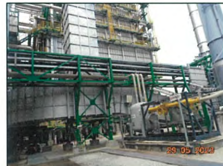
ระบบม่านไอน้ำ (Steam Curtain System)
