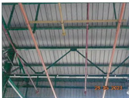
ระบบสเปรย์น้ำ (Water Spray)
