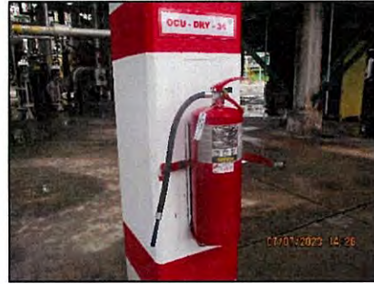
ถังดับเพลิงชนิดผงเคมีแห้ง
