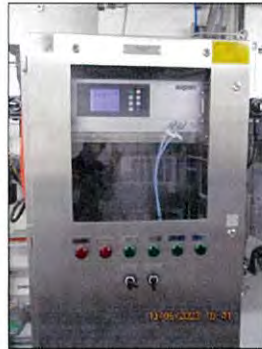
CEMs ที่ปล่อยระบายอากาศ Gas Cracking Furnace A
