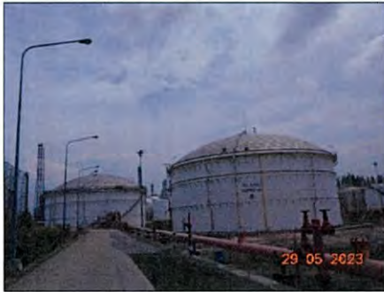
ถังเก็บวัตถุดิบแบบ Aluminium Dome Roof with Internal Floating Roof
