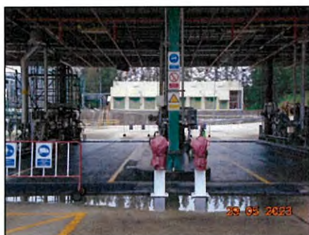
รูปที่ ก2-57 อุปกรณ์เตือนภัย และอุปกรณ์ดับเพลิง บริเวณ Truck Loading
