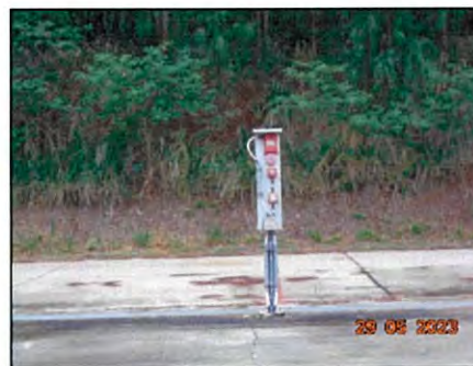
รูปที่ ก2-57 อุปกรณ์เตือนภัย และอุปกรณ์ดับเพลิง บริเวณ Truck Loading
