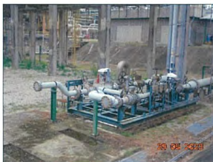
รูปที่ ก2-54 Block Valve และอุปกรณ์ลดแรงดันบริเวณแนวท่อขนส่ง
