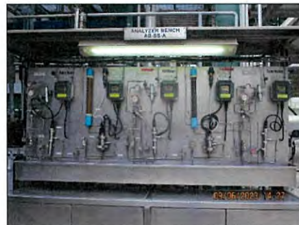
รูปที่ ก2-23 การติดตั้ง พีเอช (pH) Online ที่ Neutralization Tanks
