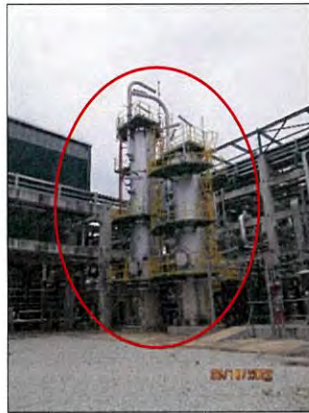
รูปที่ ก2-30 หอดูดซับของหน่วยกำจัดโลหะหนัก
