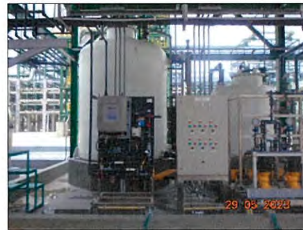
การติดตั้ง ORP Analyzer และ conductivity analyzer ที่ระบบ Cooling Water System และหน่วยผลิตโอเลฟินส์ส่วนเสริม
