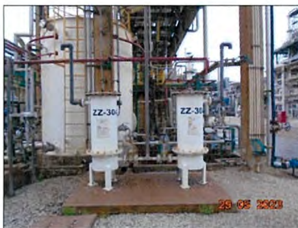
รูปที่ ก2-4 Carbon Canister ที่ใช้กำจัด Vent gas จาก Caustic Drian Drum
