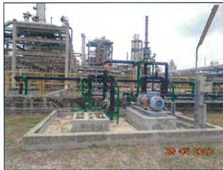
ปั๊มสูบน้ำจากบ่อ Storm Water Diversion Box
