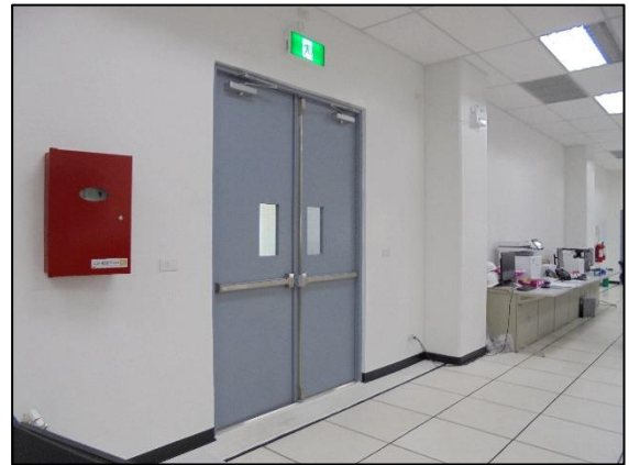
รูปที่ 2-14 ประตูและผนังที่กันเสียงสำหรับห้องควบคุม
