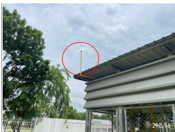
รูปที่ 3-44 ปล่องระบายก๊าซ (Blow Down Stack)
