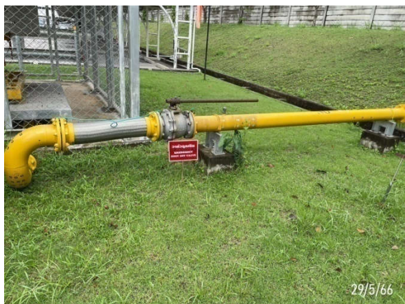
รูปที่ 3-43 วาล์วฉุกเฉิน และลูกศรแสดงทิศทางการไหลของก๊าซ
