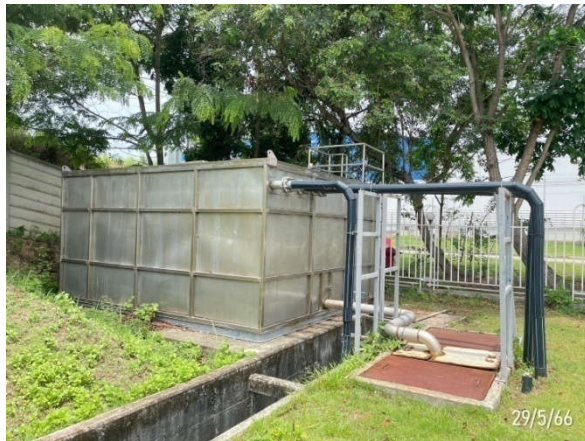
รูปที่ 3-10 บ่อพักน้ำสำหรับระบบบำบัดน้ำเสียทางชีวภาพ
