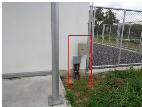
รูปที่ 3-47 การติดตั้งสายดิน
