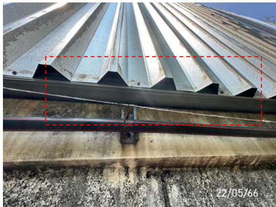
รูปที่ 2-6 ติดตั้งตัวซับเสียง (Noise Isolator) ติดกับเมทัลชีทบริเวณริมรั้วโรงงานด้านทิศใต้ที่ติดกับชุมชน
