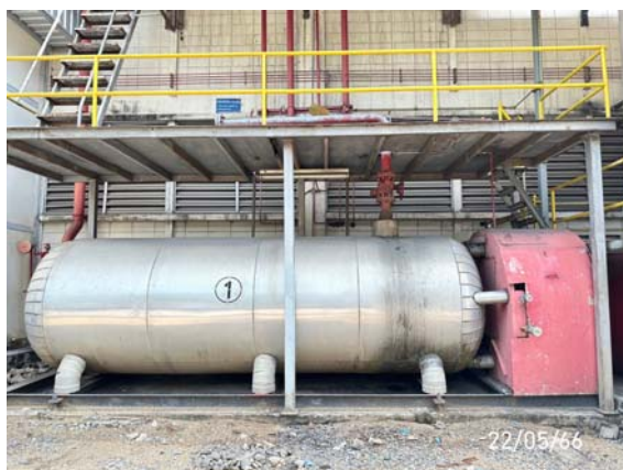
ถังดับเพลิงชนิด CO 2 ขนาด 7.5 ตัน บริเวณเครื่องรีดเย็น ชุดที่ 1
