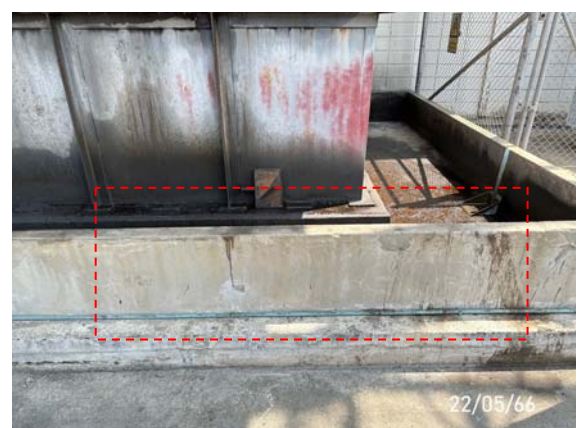
รูปที่ 2-20 กำแพงกัน Dike Wall ป้องกันกรณีเกิดการหกรั่วไหล
