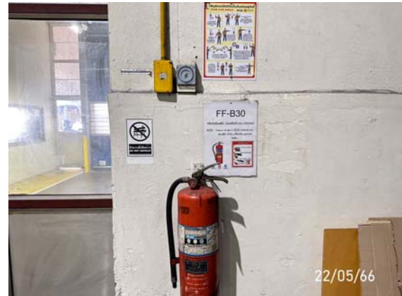
ถังดับเพลิงชนิดผงเคมีแห้ง ชนิดมือถือ
