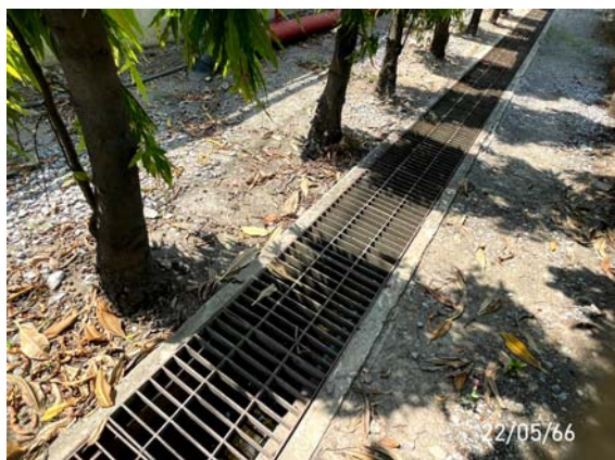
รูปที่ 2-13 ติดตั้งตะแกรงดักขยะตามรางระบายน้ำภายในพื้นที่โครงการ
