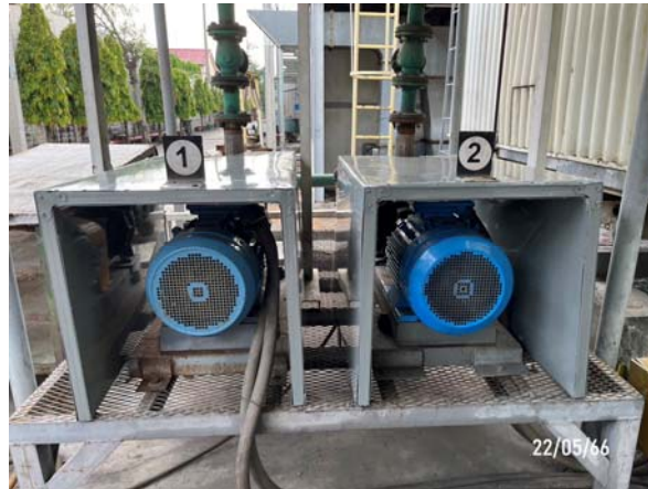
รูปที่ 2-5 ติดตั้งที่ครอบกันเสียงบริเวณปั๊มระบบบำบัดมลพิษทางอากาศ
