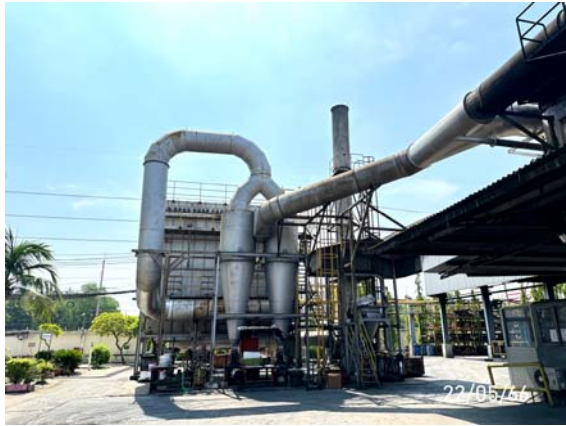
รูปที่ 2-1 ระบบดักฝุ่นละอองแบบถุงกรอง
