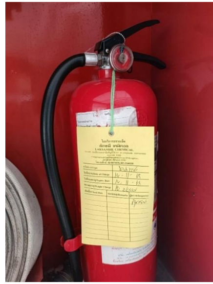
ตรวจสอบตู้สัญญาณเตือนไฟไหม้ไฟไหม้ของโครงการ ตรวจสอบถังดับเพลิงแบบมือถือ Exp.14/11/68
