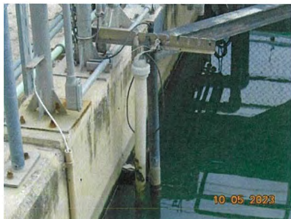
ภาพที่ 2.2-13 Level Switch บริเวณบ่อพักน้ำทิ้ง
