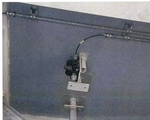
ภาพที่ 2.2-39 เครื่องตรวจจับการรั่วไหลของก๊าซธรรมชาติ
