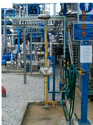
ภาพที่ 2.2-32 อุปกรณ์ชำระล้างฉุกเฉิน (Emergency Shower and Eye Wash Fountain)
