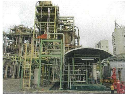
ภาพที่ 2-5 หน่วนำกลับไอสารไฮโดรคาร์บอน (VOC Recovery Unit: VRU) ของโรงงานที่ 2
