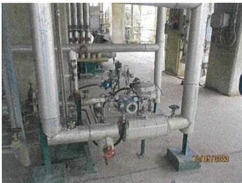
ภาพที่ 2-2 ระบบาล์วควบคุมระหว่างถังปฏิกรณ์
