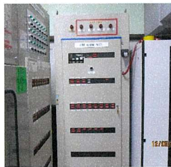
ภาพที่ 2-20 Gas Detector และแผงแสดงสัญญาณในห้องควบคุม
