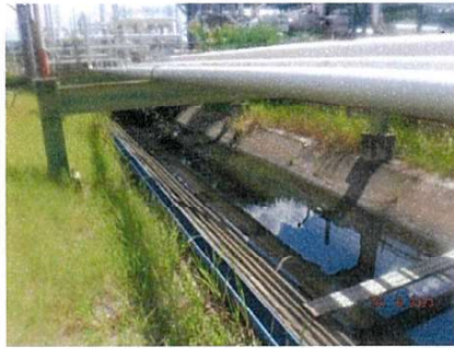
ภาพที่ 2-33 การทำคูป้องกันบริเวณแนวท่อขนส่ง Vent Gas และ Nitrogen
