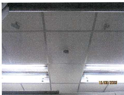
ภาพที่ 2-21 Smoke Detector
