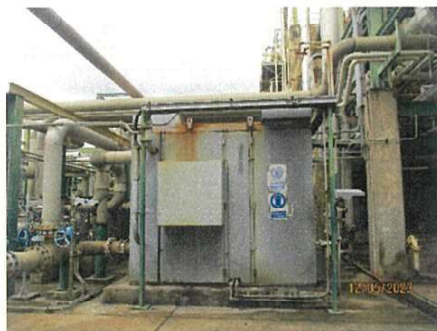
ภาพที่ 2-12 กล่องครอบลดเสียงดังจากเครื่องจักร
