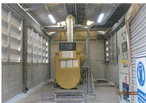
ภาพที่ 2-27 Diesel Generator
