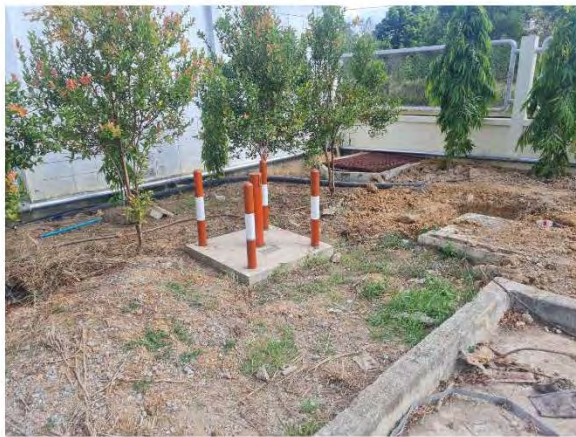
ภาพที่ 3.14 บ่อสังเกตการณ์ตรวจสอบ คุณภาพน้ำใต้ดิน
