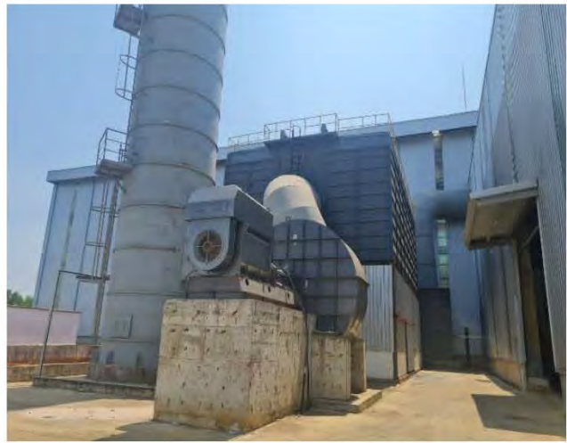
ภาพที่ 3.2 ระบบดักฝุ่นแบบถุงกรอง
