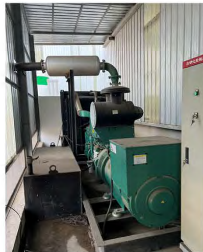
ภาพที่ 3.4 เครื่องไฟฟ้าสำรองของระบบดูดอากาศ
