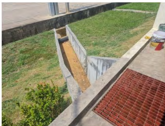
ภาพที่ 3.16 รางระบายน้ำฝนของโครงการ
