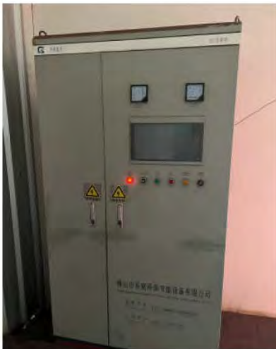
ภาพที่ 3.3 อุปกรณ์ตรวจวัดความดัน ของเครื่องดักฝุ่นแบบถุงกรอง
