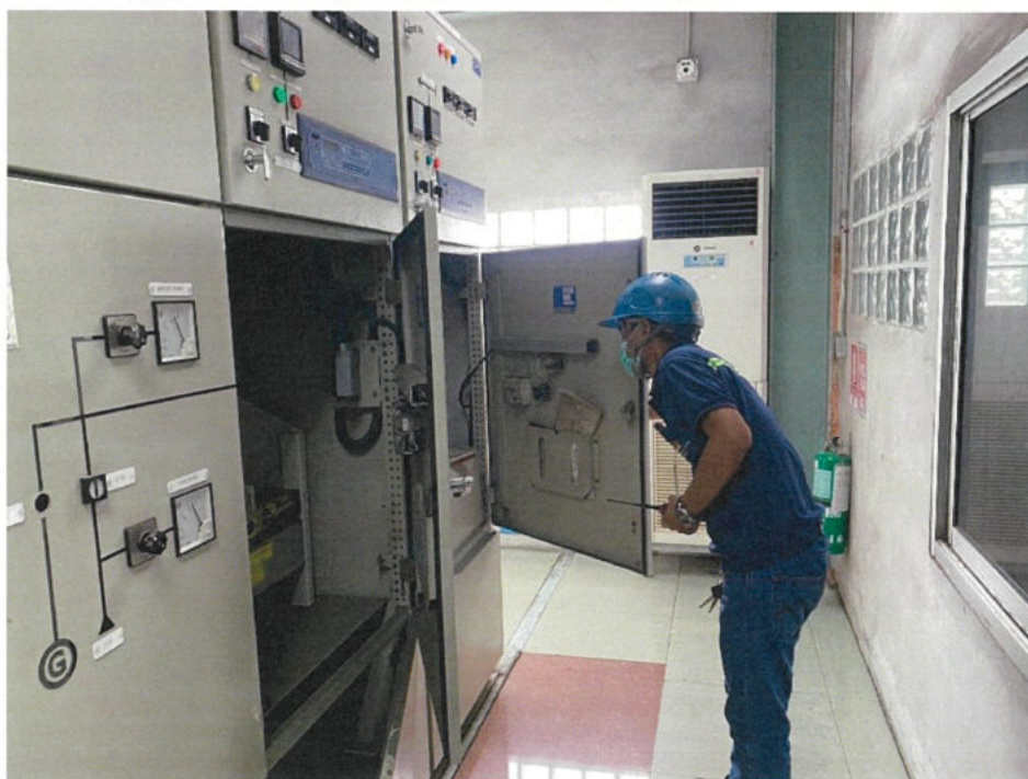
หัวหน้ากะแผนกไฟฟ้าเข้าตรวจสอบความเสียหายเบื้องต้น พบว่า TP อุปกรณ์ภายใน ตู้ 52-T2 (6.6 KV 2000V BUSTIE PANEL) ได้รับเสียหาย และอุปกรณ์อื่นๆ และตู้ MDB อื่นไม่ได้รับผลกระทบ
