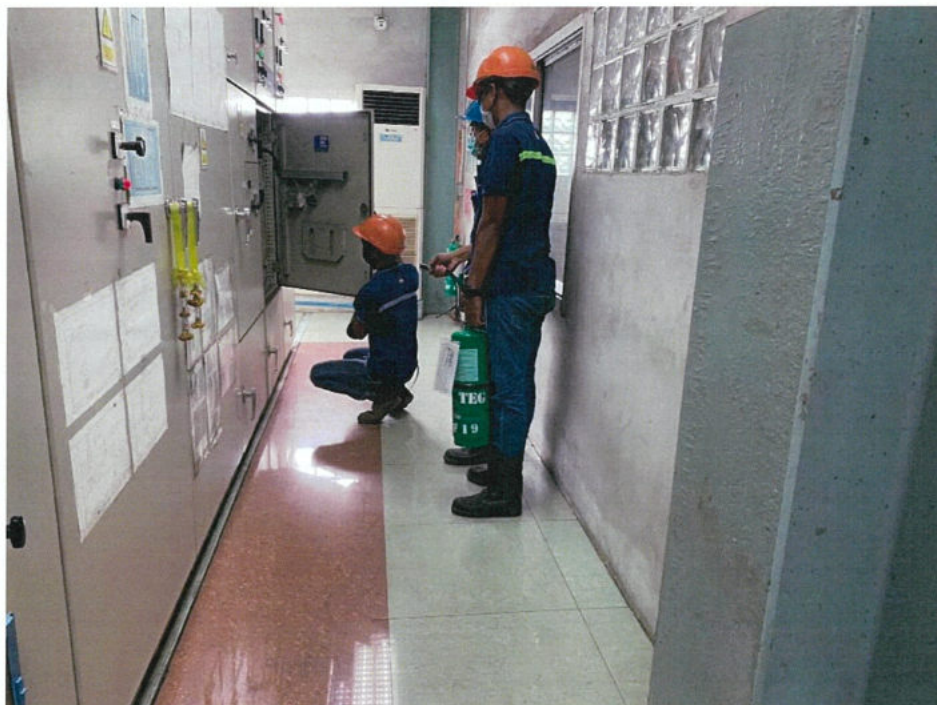
พนักงานไฟฟ้าเข้าระงับเบื้องต้น โดยสวมถุงมือป้องกันไฟดูด ก่อนเปิดตู้ S2-T2 (6.6 KV 2000V BUSTIE PANEL) เพื่อใช้ถังดับเพลิงชนิดดับไฟ
