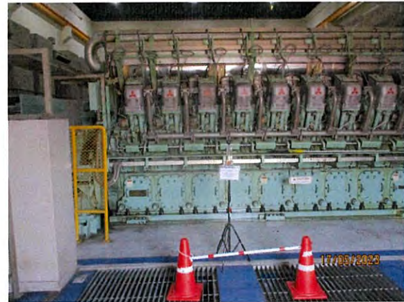
บริเวณเครื่องกำเนิดไฟฟ้าแบบเครื่องยนต์ก๊าซ
