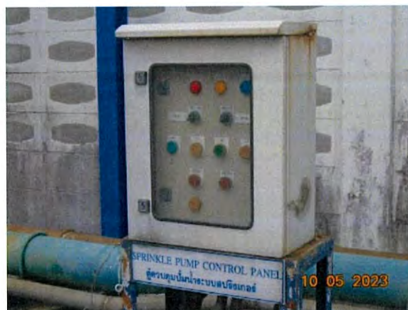
ภาพที่ 2.2-26 ตู้ควบคุมปั้มน้ำทิ้งกลับมาใช้รดน้ำต้นไม้
