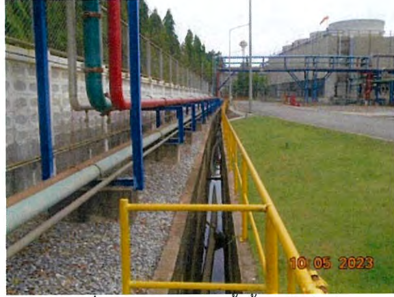
ภาพที่ 2.2-23 รางระบายน้ำทิ้งของโรงไฟฟ้า
