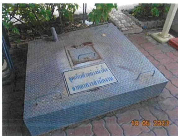
ภาพที่ 2.2-19 บ่อตรวจสอบคุณภาพน้ำทิ้งจากอาคาร สำนักงาน
