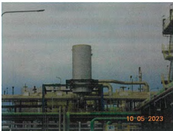
ภาพที่ 2.2-16 ตัวเก็บเสียง ( Silencer)
