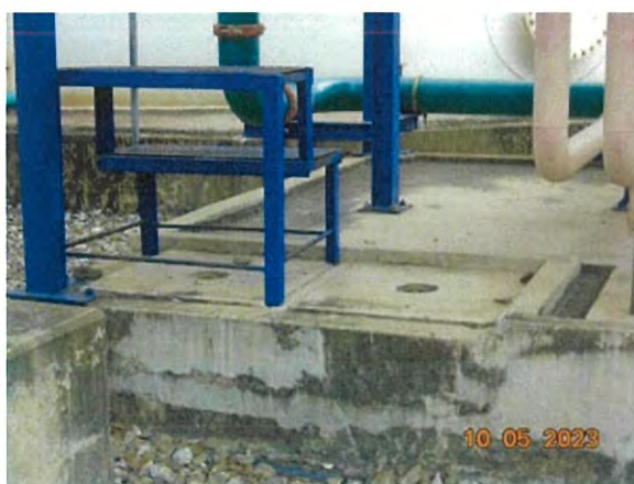
ภาพที่ 2.2-18 ถังแยกน้ำ-น้ำมัน (Oil Separator)
