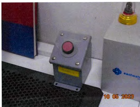
ภาพที่ 2.2-56 ปุ่ม Emergency shutdown
