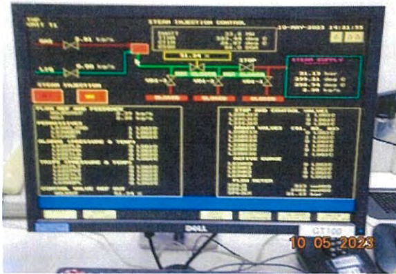
ภาพที่ 2.2-6 หน้าจอควบคุม NOx โดยใช้ steam injection system
