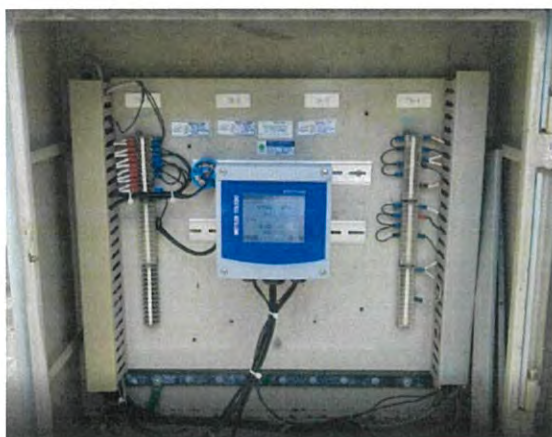
ภาพที่ 2.2-20 เครื่องแสดงผลการตรวจวัดค่าความเป็นกรด-ด่าง อุณหภูมิ และค่าความนำไฟฟ้าแบบอัตโนมัติ
