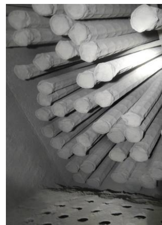
รูปที่ 9 การเปลี่ยนและตรวจสอบถุงกรอง
