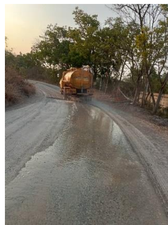
รูปที่ 13 รถฉีดพรมน้ำบริเวณหน้าเหมือง และเส้นทางขนส่งแร่
