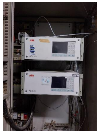
รูปที่ 7 ระบบเตือน (Alarm) ของ CO/O 2 Analyzer
