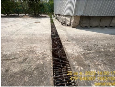
รูปที่ 40 รางระบายน้ำ บริเวณอาคารเก็บเชื้อเพลิงชีวมวล
