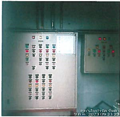
รูปที่ 28 ตู้ควบคุมระบบบำบัดน้ำเสีย
