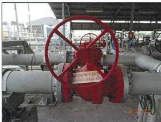
ภาพถ่ายที่ 2.2-39 อุปกรณ์ตัดระบบการลำเลียงก๊าซกรณีฉุกเฉิน
