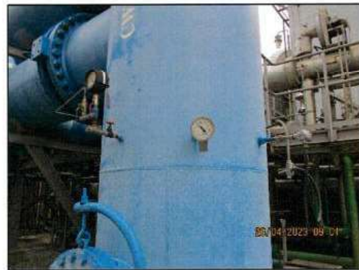
ภาพถ่ายที่ 2.2-12 เครื่องวัดอุณหภูมิของหล่อเย็น
