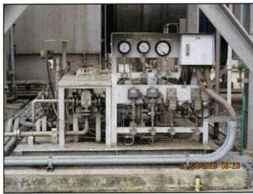
De-NO x Water System HRSG#4
