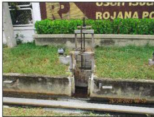
ภาพถ่ายที่ 2.2-19 ประตูกันน้ำที่จุดเชื่อมต่อระหว่างรางรวบรวมน้ำฝนภายในโครงการและ รางรวบรวมน้ำฝนของสวนอุตสาหกรรม
