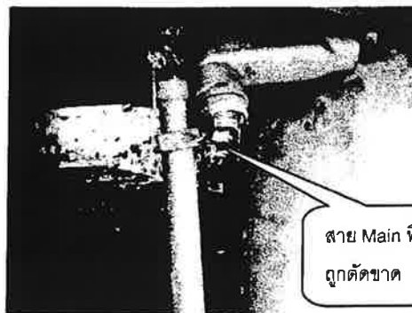
รูปที่ 2 สายไฟฟ้า Main ถูกตัดขาดก่อนเข้าสู่สถานี
