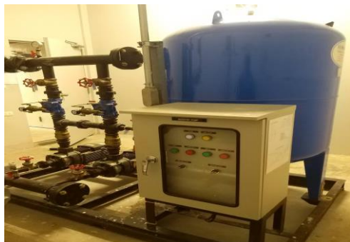
ปั๊ม และถังเก็บน้ำสำรองชั้นดาดฟ้า ภาพที่ 2.2-9 ระบบน้ำใช้โครงการ
