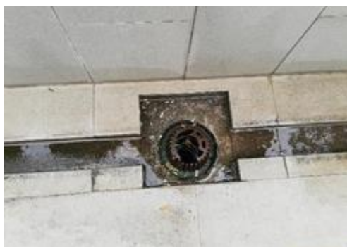
ท่อระบายน้ำฝนจากชั้นหลังคา
