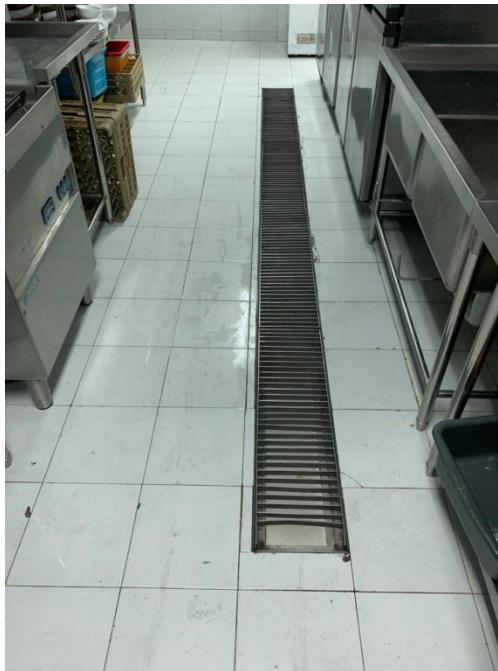
ภาพที่ 13 แสดงรางระบายน้ำภายในห้องครัว
