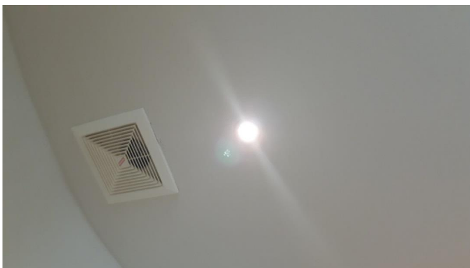
ภาพที่ 20 แสดงพัดลมดูดอากาศและหลอดประหยัดไฟฟ้าชนิด LED ภายในห้องพัก
