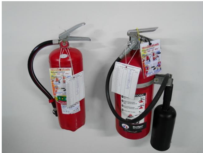
ภาพที่ 31 แสดงถังดับเพลิงชนิดเคมีผงแห้งและวิธีการใช้
