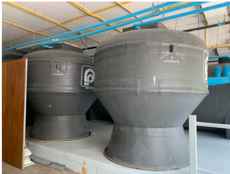
ภาพที่ 5 แสดงจุดบำบัดน้ำเสียรวม
