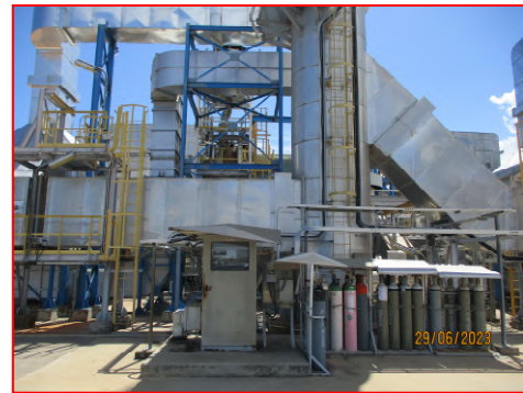
(12) ระบบ CEMs บริเวณ Boiler Stack Vent Gas
