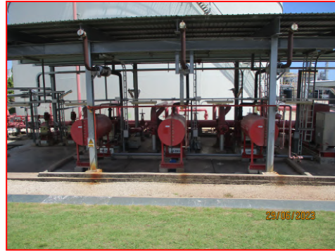
(61) เครื่องสูบน้ำดับเพลิง
