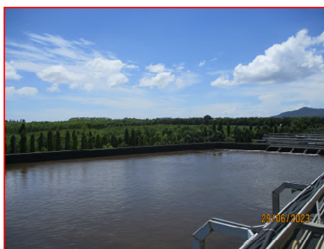
(20) บ่อพักน้ำเสีย (Polishing Pond)
