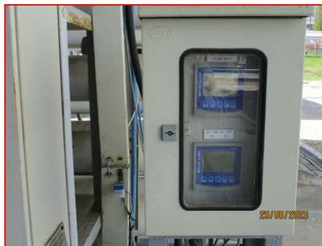
(26) Conductivity Online Analyzer บริเวณระบบ RO
