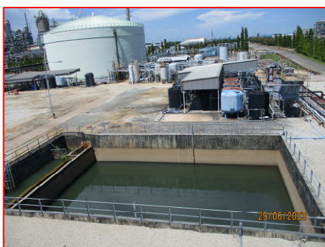
(34) บ่อพักน้ำฝนที่มีโอกาสปนเปื้อน
