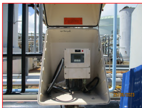
(27) Conductivity Online Analyzer บริเวณก่อนระบบ ออกนอกโครงการ
