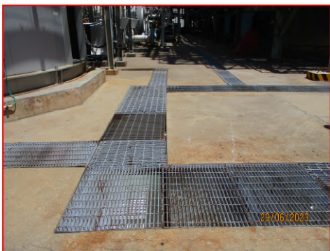
(23) รางรวบรวมน้ำเสียจากพื้นที่กระบวนการผลิต
