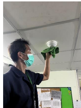
ตรวจสอบ Smoke Detector
