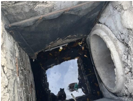
ตะแกรงดักขยะ ก่อนปล่อยน้ำออกนอกโครงการ
