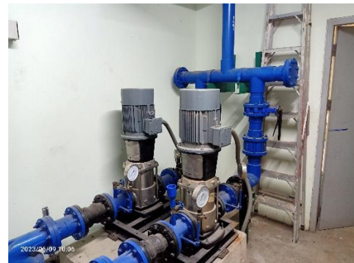
ปั๊มสูบน้ำขึ้นไปเก็บถังเก็บน้ำชั้นหลังคา
