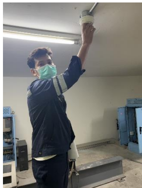
ตรวจสอบ Heat Detector
