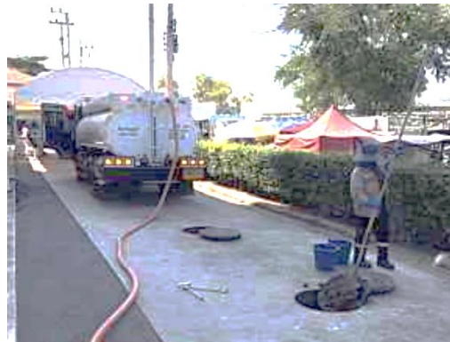
สูบน้ำมันและตะกอนส่วนเกิน
