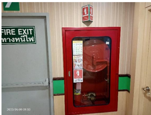
ตู้ FHC (มีสายยางดับเพลิง และถังเคมีดับเพลิง) และป้ายแสดงวิธีการใช้อุปกรณ์ดับเพลิง
