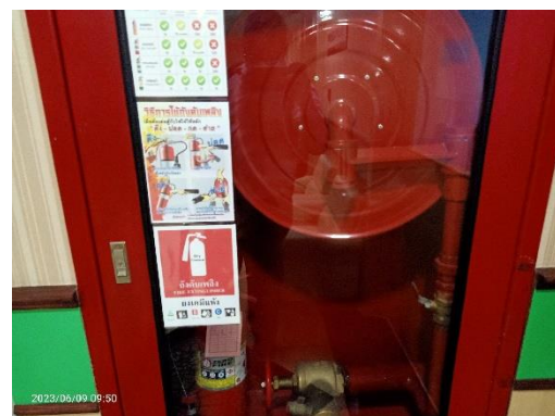
ตู้ FHC (มีสายยางดับเพลิง และถังเคมีดับเพลิง) และป้ายแสดงวิธีการใช้อุปกรณ์ดับเพลิง
