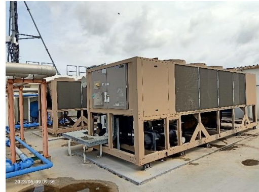
ภาพที่ 2-29 ระบบทำน้ำเย็นชนิดระบายความร้อนด้วยอากาศ (Air Cooled Water Chiller)
