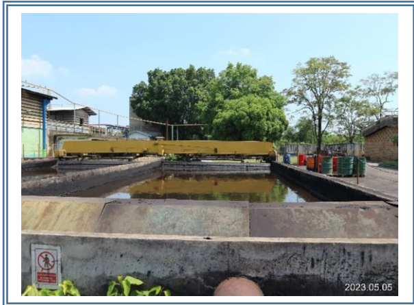
รูปที่ 3.6 ปอดักคราบน้ำมันและจาระบีภายในโครงการ
