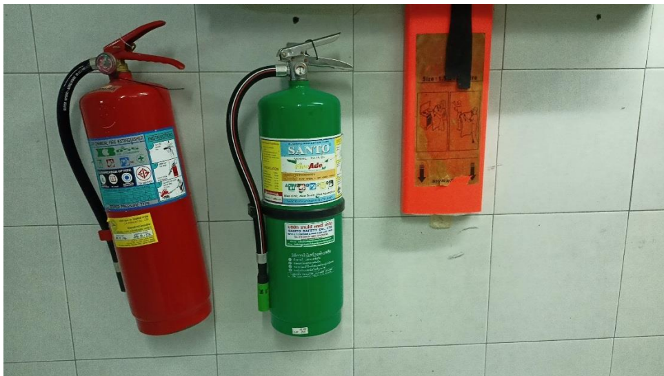
ภาพที่ 31 แสดงถึงดับเพลิงชนิดเคมีผงแห้งและวิธีการใช้
