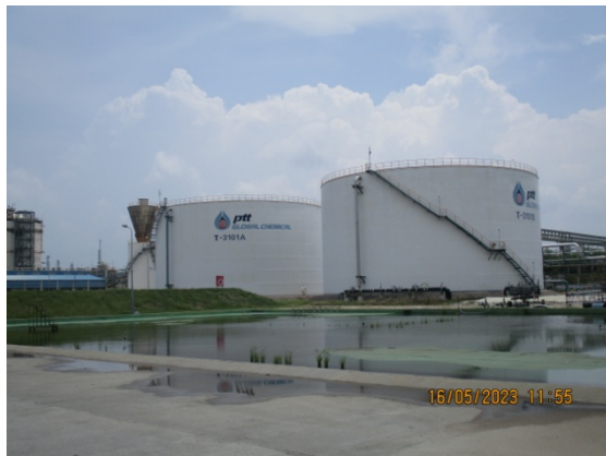
รูปที่ 56 Fire Water Tank (15,000 m 3 )
