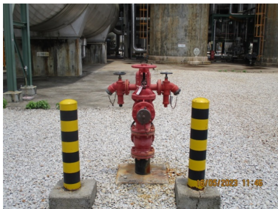
รูปที่ 50 Water Hydrants (Indoor & Outdoor)
