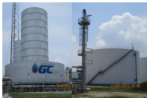
รูปที่ 4 หอเผาความดันต่ำ หอเผาความดันสูง และหอเผานิต EGF
