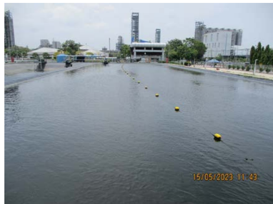
รูปที่ 16 บ่อพักน้ำทิ้งขนาด 4,000 ลบ.ม.
