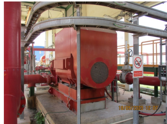
รูปที่ 57 Electric Fire Pump
