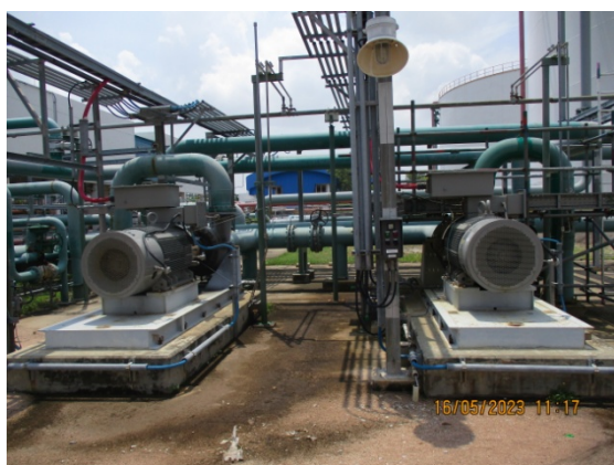
รูปที่ 58 Electric Jockey Pump
