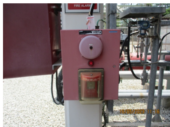
รูปที่ 53 Manual Fire Alarm
