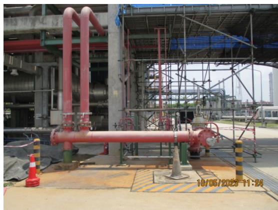
รูปที่ 45 Wet Spray System
