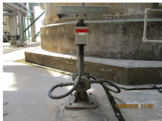
รูปที่ 42 Fixed Gas Detector
