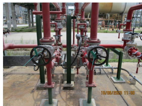
รูปที่ 47 Deluge Valve System
