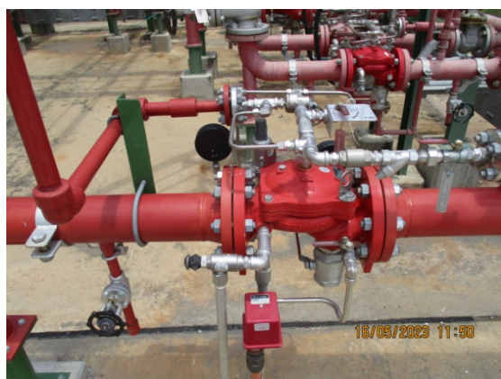
รูปที่ 47 Deluge Valve System
