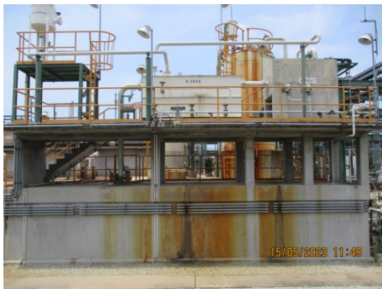
รูปที่ 9 ถังแยกน้ำมันแบบ CPI Oil Separator
