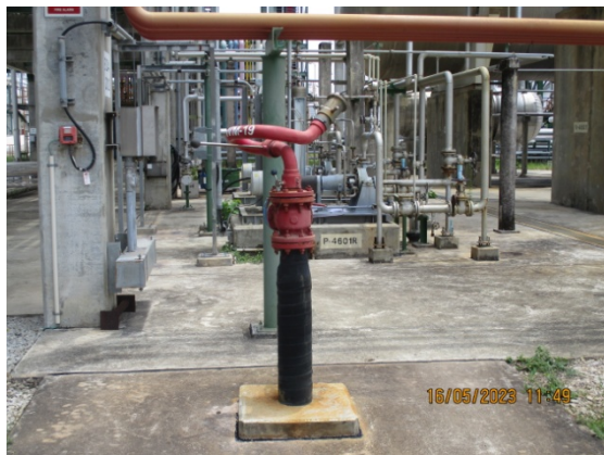
รูปที่ 48 Water Fix Monitor
