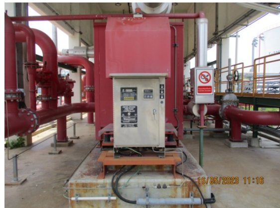
รูปที่ 55 Diesel Fire Pump
