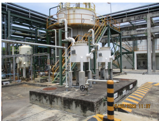
รูปที่ 11 ถังแยกน้ำมันแบบ DAF
