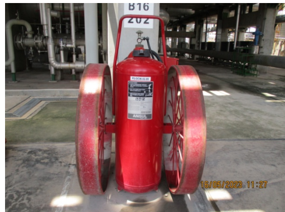
รูปที่ 49 Wheeled Fire Extinguisher
