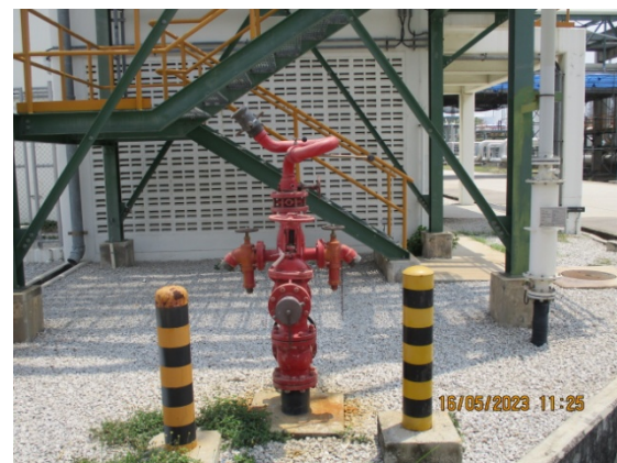
รูปที่ 46 Water Hydrants with Monitors
