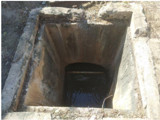
ตรวจสอบปริมาณตะกอนบ่อกักน้ำ
